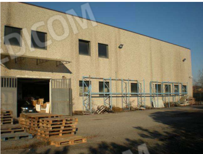
Foto 9 lato sud vista da cortile
