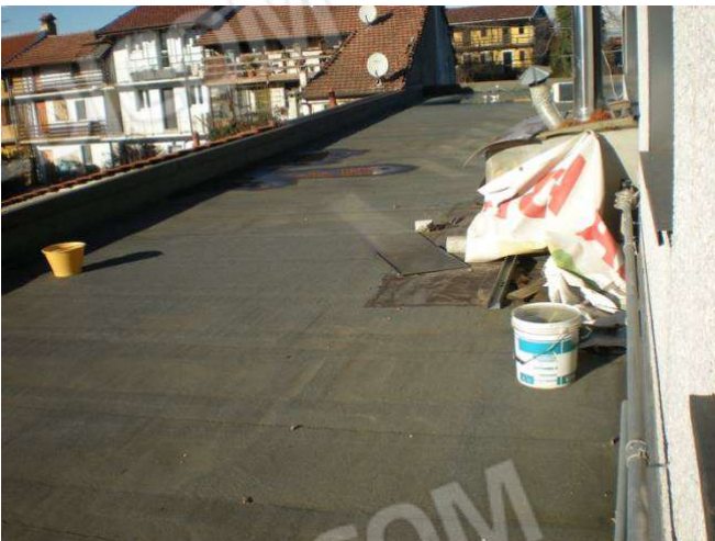
Foto 33 solaio di copertura lato ovest
