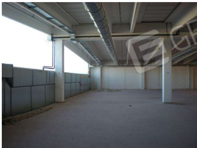
Foto 34 area non accessibile al 1°P.
