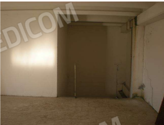
Foto 30 deposito 1°P. vuoto su solaio
