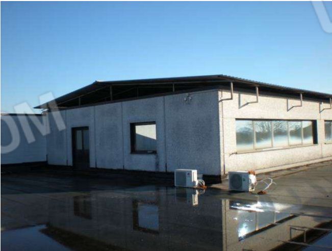
Foto 41 vista deposito 1°P.
