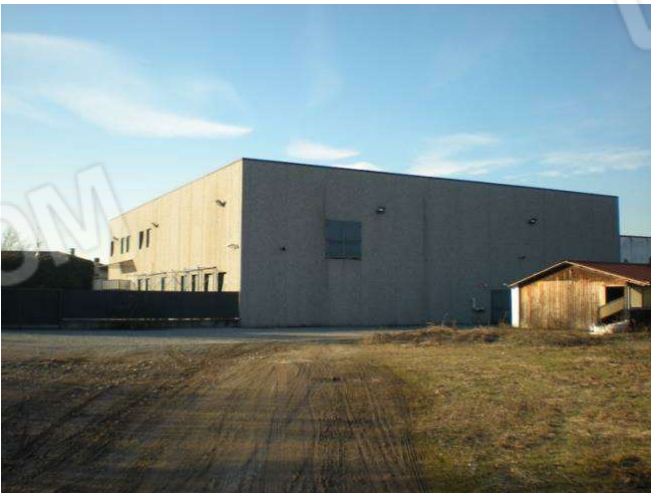
Foto 11 vista complessiva capannone lati est-sud
