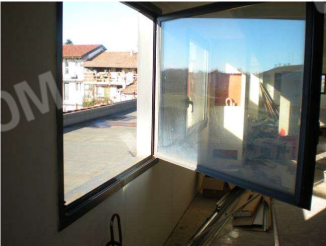
Foto 32 deposito 1°P. vista solaio di copertura
