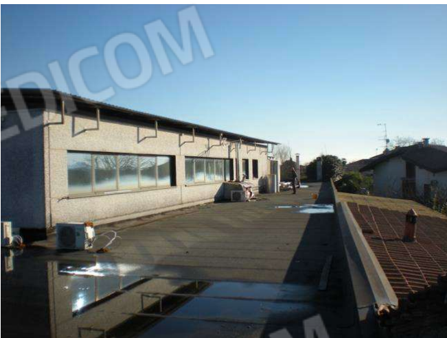
Foto 42 lato ovest deposito e adiacenze altre proprietà
