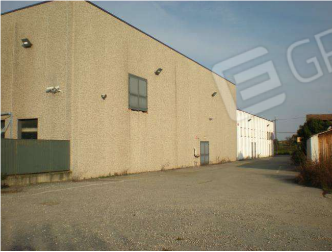
Foto 7 lato est parte ampliamento
