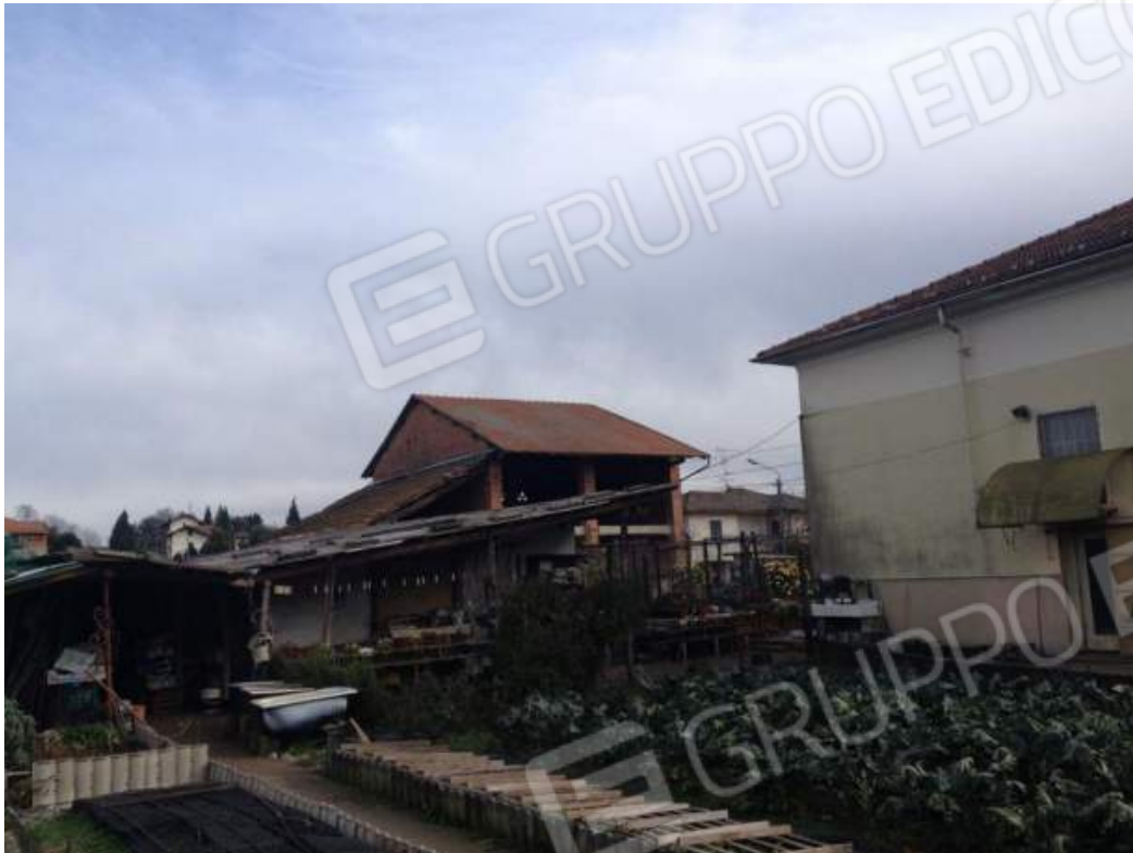
IMMOBILE in Gattico (D) e (B) – prospetto sud-ovest - vista da corte interna (C.3)
