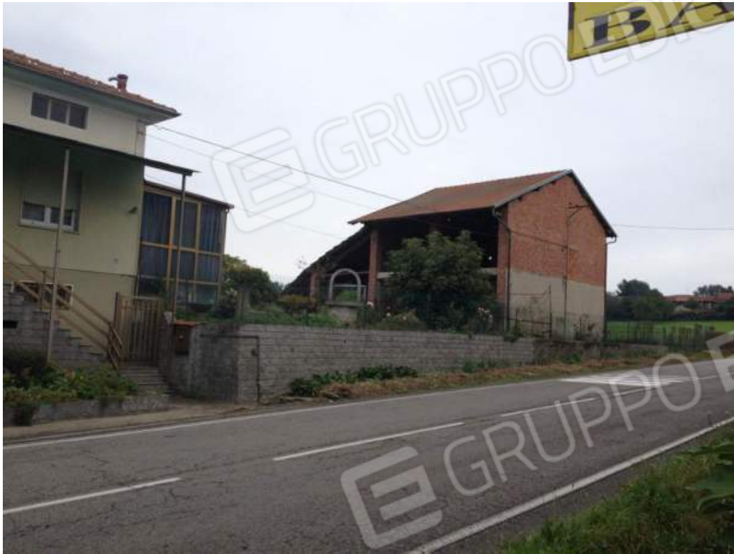
IMMOBILE in Gattico (B) prospetto sud-est vista da corso Garibaldi
