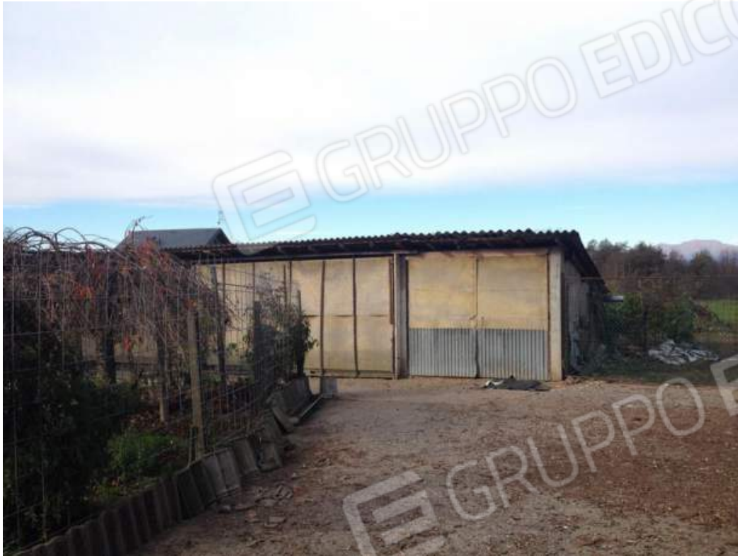
IMMOBILE in Gattico (D) - vista da corte interna
