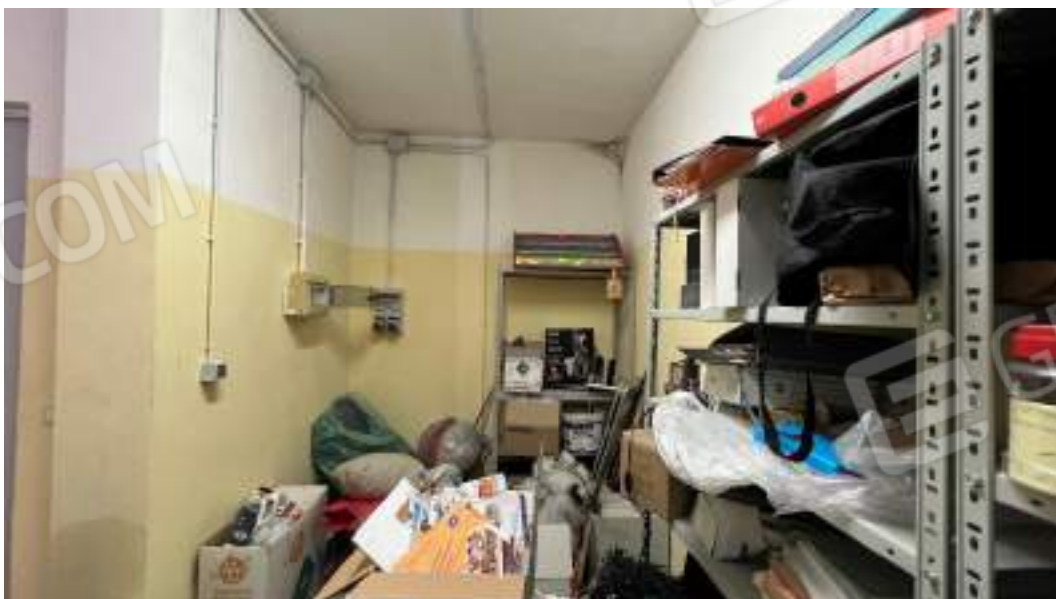
Figura 20 – Viste interne dello spazio adibito a locale Bar – piano interrato
