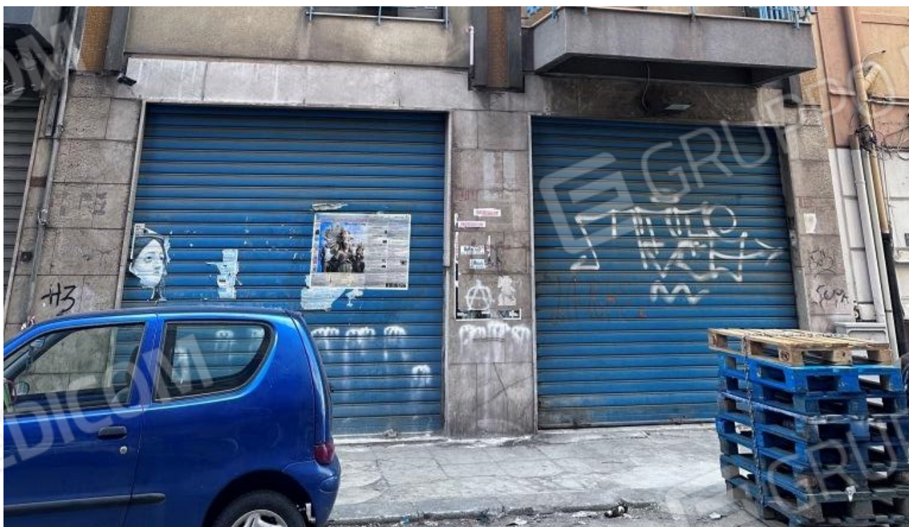
Foto n. 2 - Prospetto via V. La Mantia all'altezza del civico 146 D - E.
