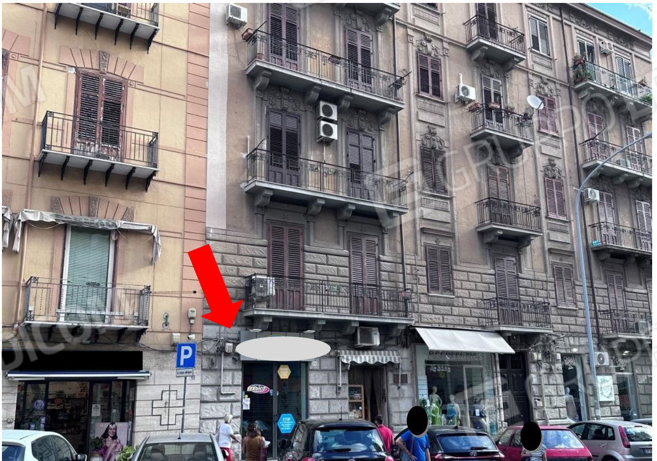
Foto n. 1 - Ingresso all'u.i.u. da Corso Camillo Finocchiaro Aprile all'altezza del civico 131.
