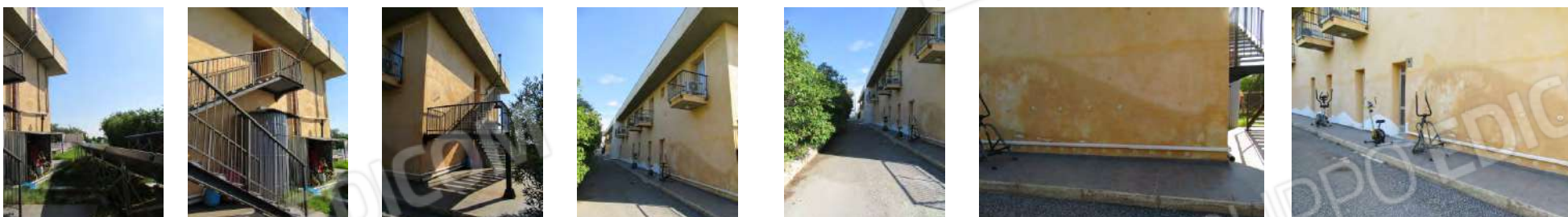
Foto da 251 a 254 – Prospetto Ovest
