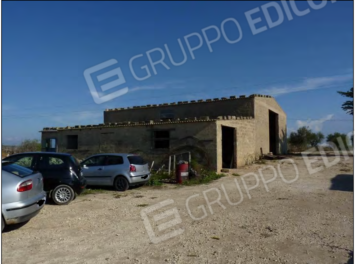
FABBRICATI RICADENTI IN PARTE NELLA PARTICELLA 936 ED IN PARTE NELLA P.LLA 935, NON OGGETTO DI PIGNORAMENTO - FOTO 87
