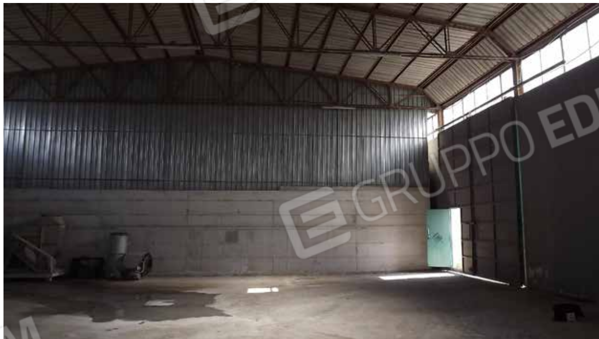
Foto.22 - Capannone adibito a deposito.
