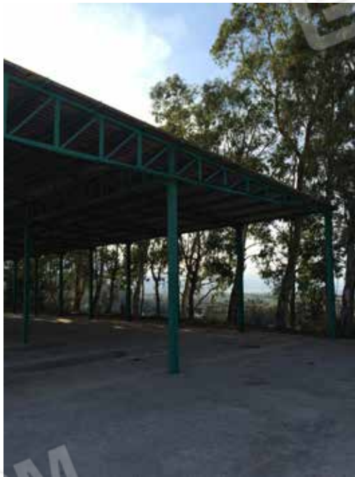
Foto.27 -Tettoia di cui si prevede la demolizione.
