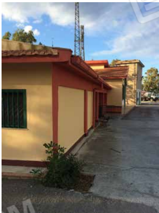
Foto.48 - Corpi di fabbrica comunicanti adibiti ad ufficio.
