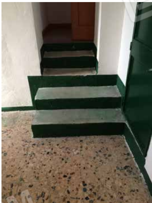
Foto.64 - Corpi di fabbrica comunicanti adibiti ad ufficio.
