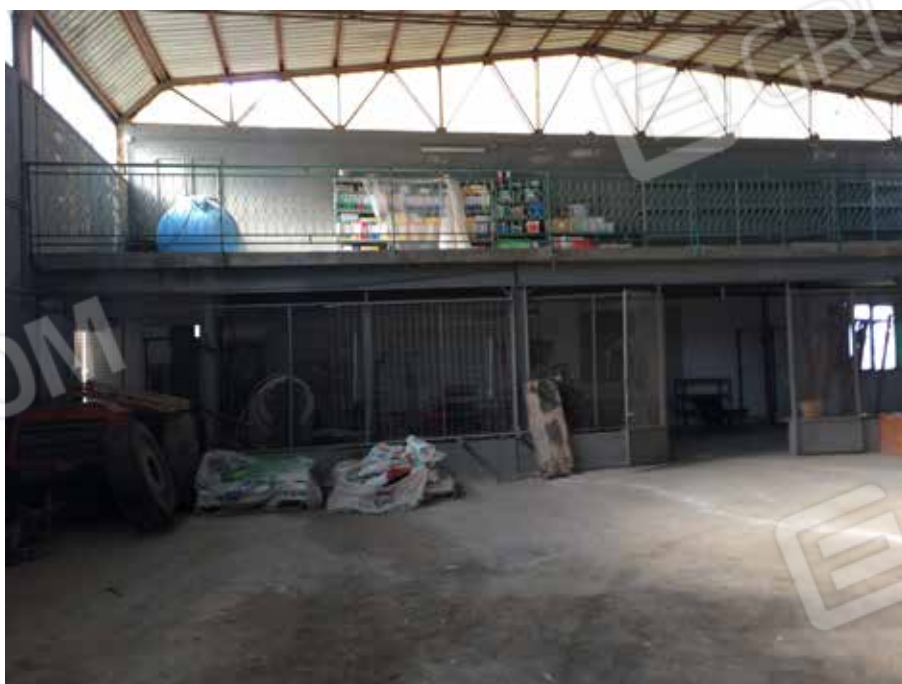
Foto.23 - Capannone adibito a deposito.
