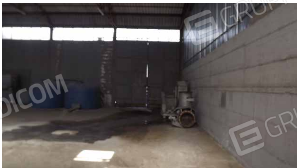
Foto.17 - Capannone adibito a deposito.
