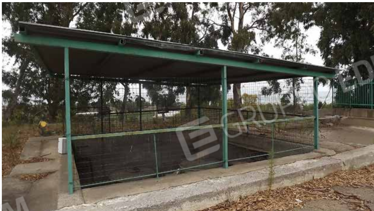
Foto.42 - Impianto di raccolta delle acque piovane in disuso.
