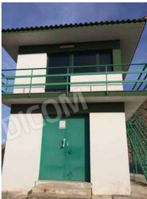
Foto.29 -Cabina di comando dell'impianto.
