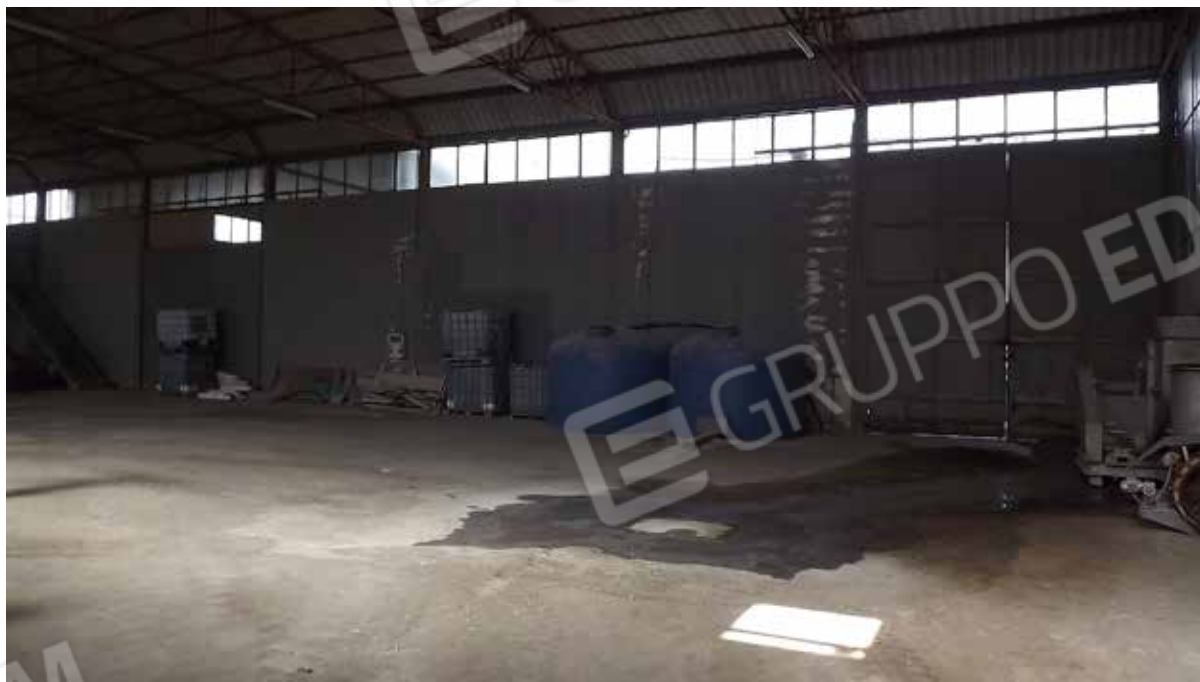
Foto.18 - Capannone adibito a deposito.
