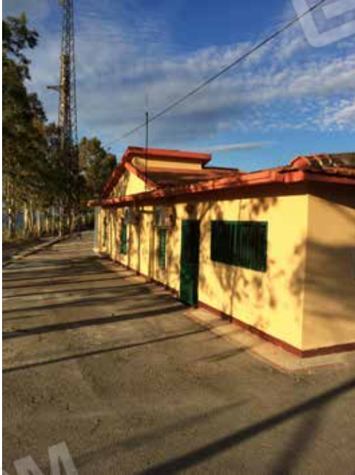
Foto.52 - Corpi di fabbrica comunicanti adibiti ad ufficio.
