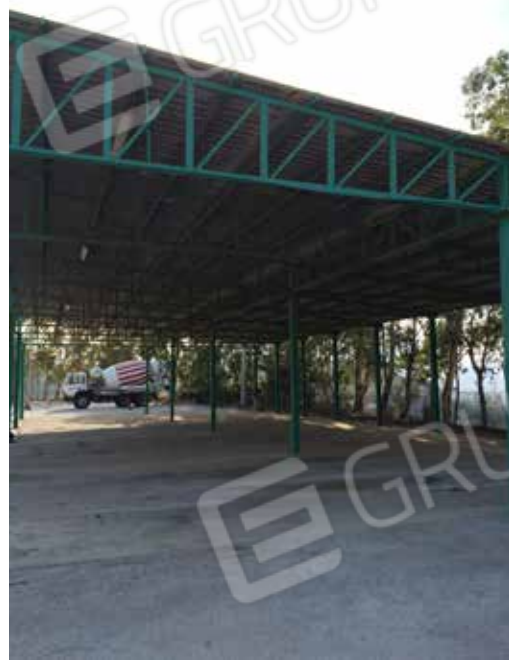
Foto.26 -Tettoia di cui si prevede la demolizione.
