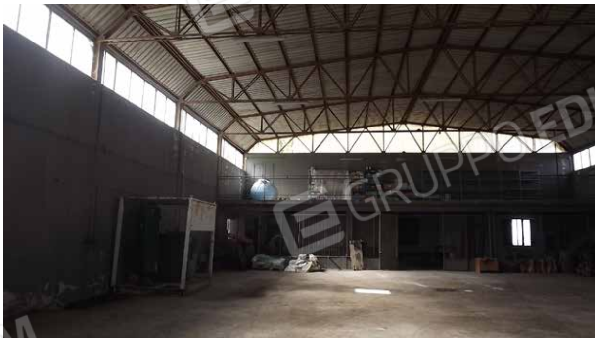
Foto.20 - Capannone adibito a deposito.
