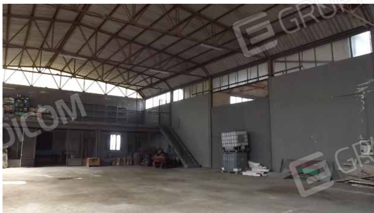
Foto.19 - Capannone adibito a deposito.
