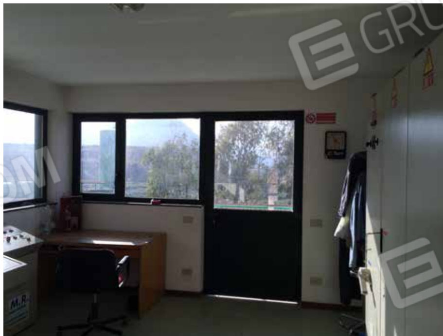
Foto.33 -Cabina di comando dell'impianto.
