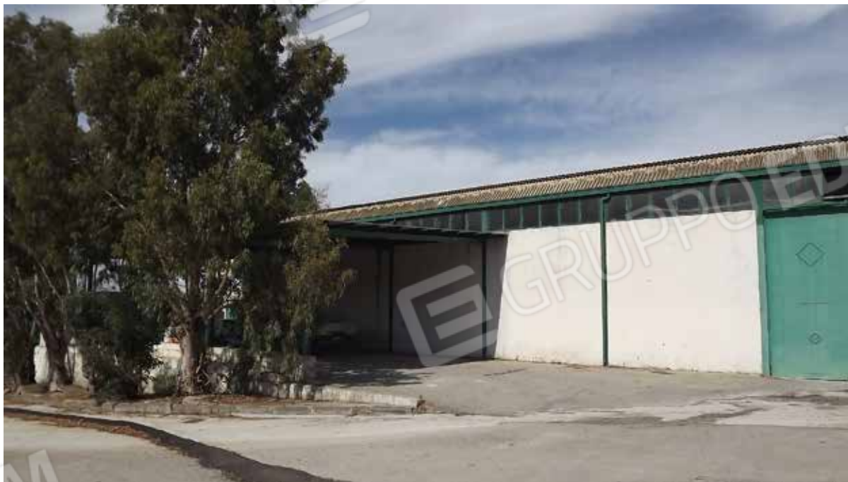
Foto.9 - Impianto di produzione di conglomerato bituminoso, area di pertinenza.
