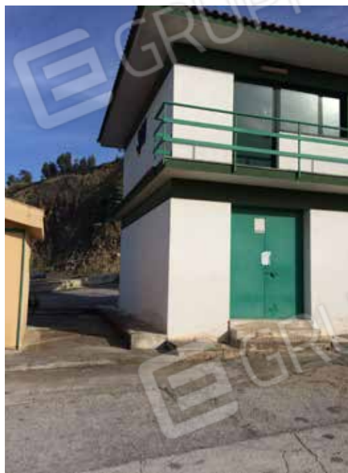
Foto.30 -Cabina di comando dell'impianto.
