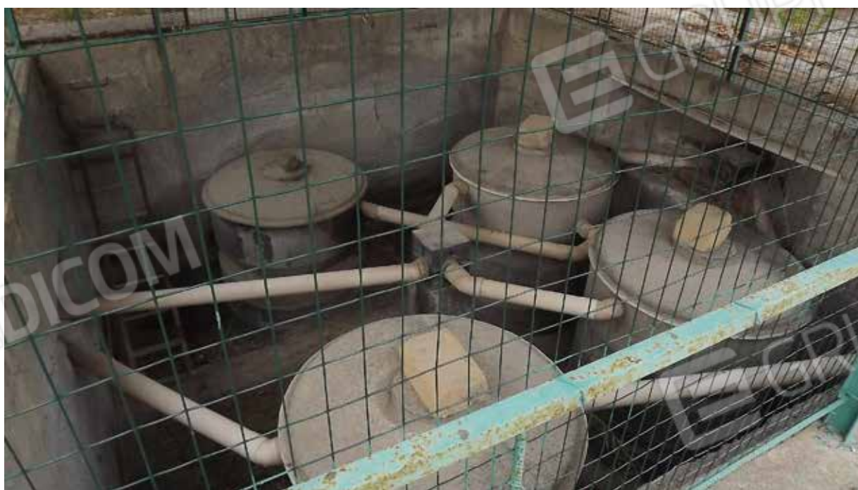
Foto.43 - Impianto di raccolta delle acque piovane in disuso.
