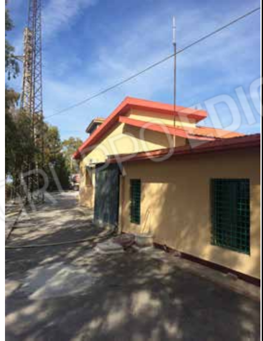
Foto.53 - Corpi di fabbrica comunicanti adibiti ad ufficio.
