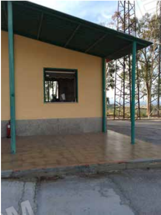
Foto.44 - Corpi di fabbrica comunicanti adibiti ad ufficio.
