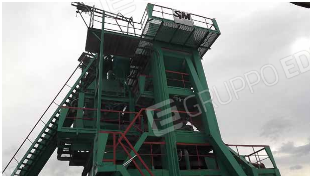
Foto.38 - Impianto di produzione di conglomerato bituminoso ed elementi strumentali all'attività dello stesso.
