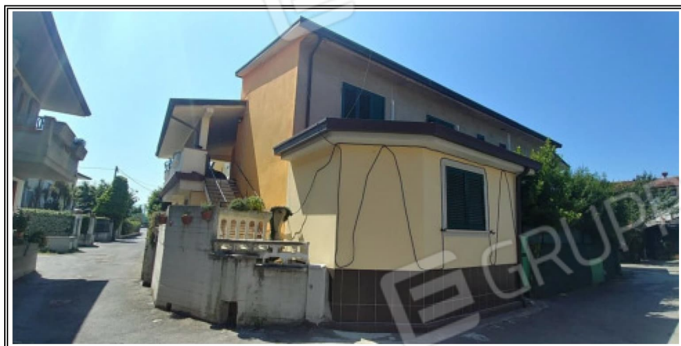
Foto n. 2 – Vista del Fabbricato angolo NORD
