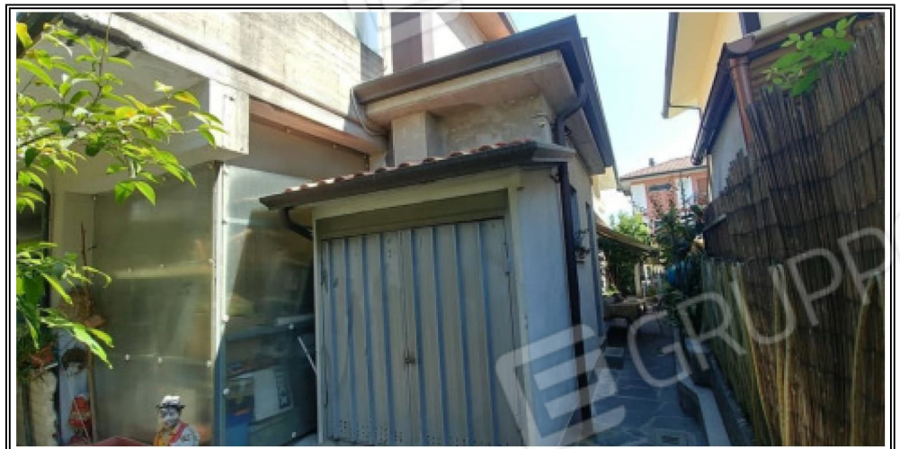
Foto n. 5 – Vista del Fabbricato angolo SUD
