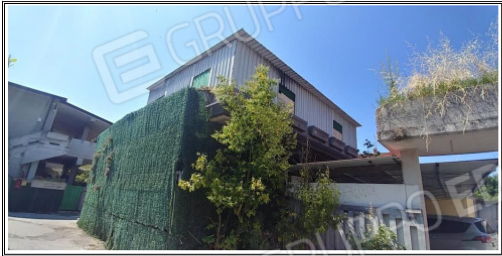
Foto n. 16 – Manufatto ad uso magazzino realizzato abusivamente
