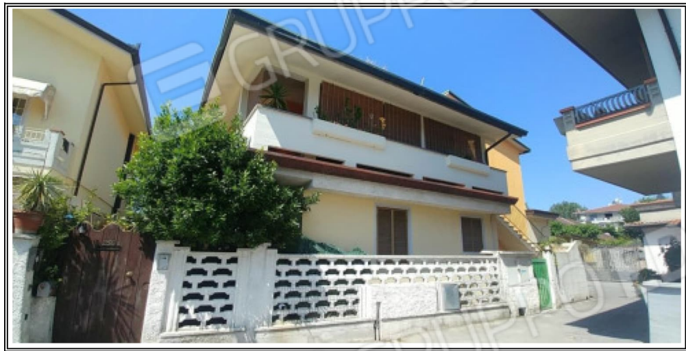
Foto n. 1 – Vista del fabbricato angolo EST
