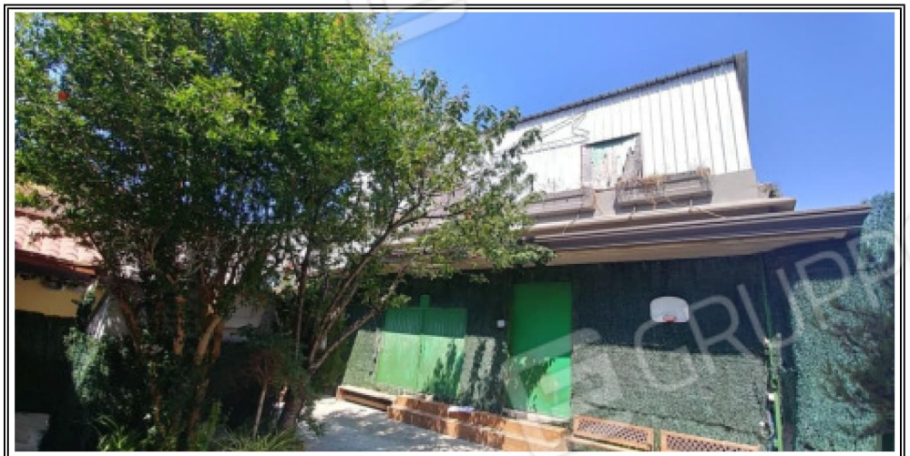
Foto n. 17 – Manufatto ad uso magazzino realizzato abusivamente
