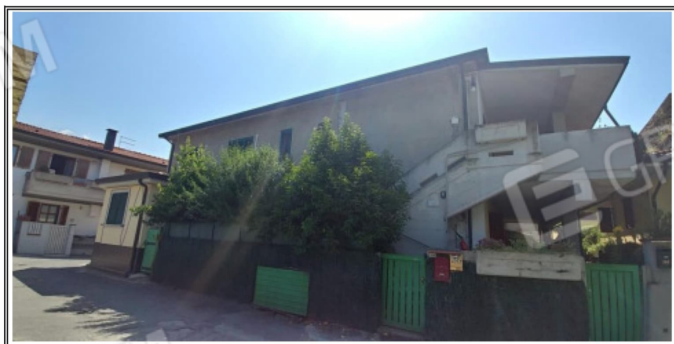
Foto n. 3 – Vista del fabbricato angolo OVEST
