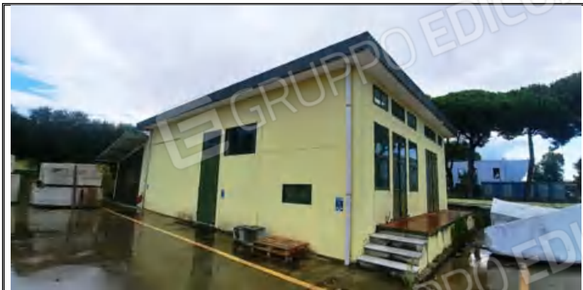
Foto n. 49– Corpo C – Magazzino mappale 548 – Angolo OVEST
