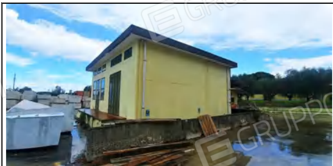
Foto n. 50– Corpo C – Magazzino mappale 548 – Angolo SUD
