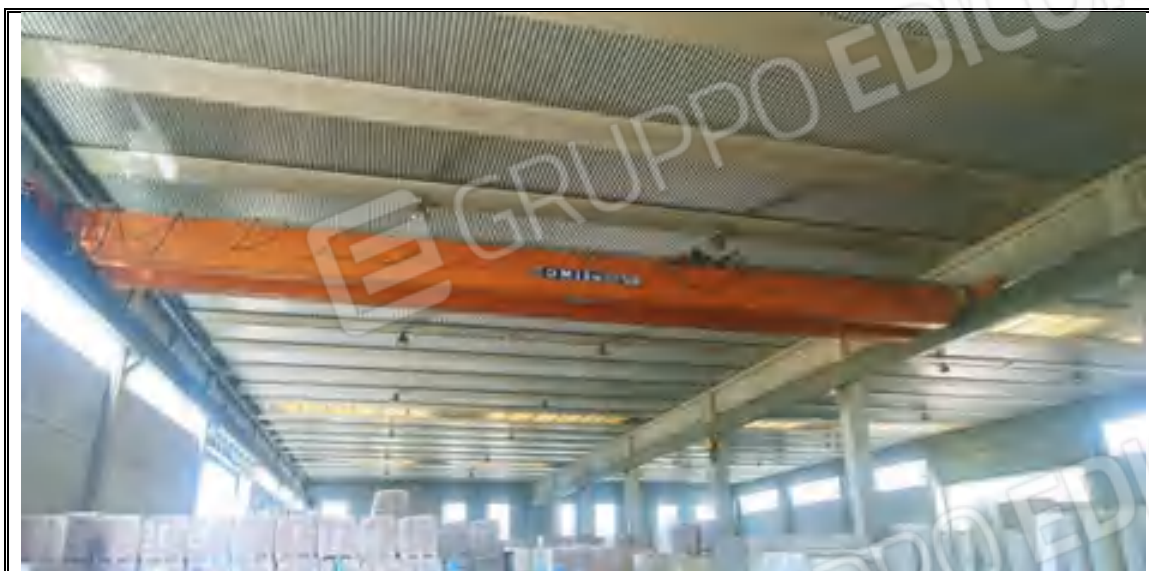
Foto n. 70– Corpo C – Capannone mappale 547 – Carroponte
