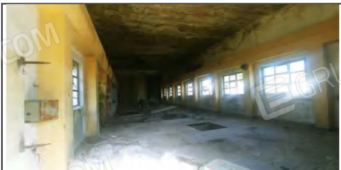
Foto n. 81 – Corpo D – Ex stazione pompaggio mappale 470 – Interno
