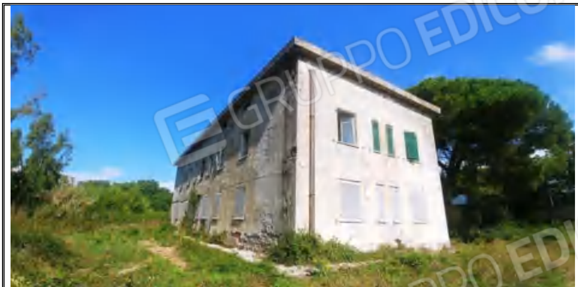
Foto n. 7– Corpo A - Fabbricato mappale 282 – Angolo SUD
