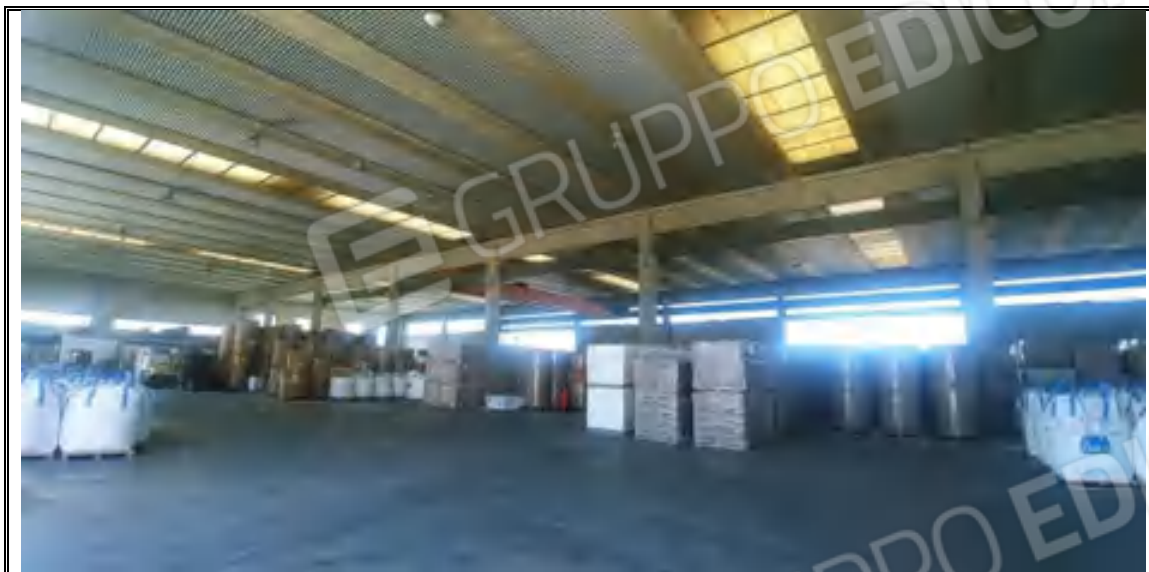
Foto n. 58– Corpo C – Capannone mappale 547 – Stoccaggio merci
