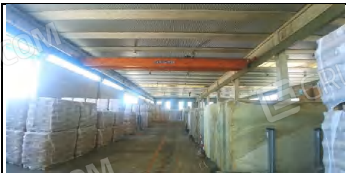
Foto n. 60 – Corpo C – Capannone mappale 547 – Stoccaggio merci
