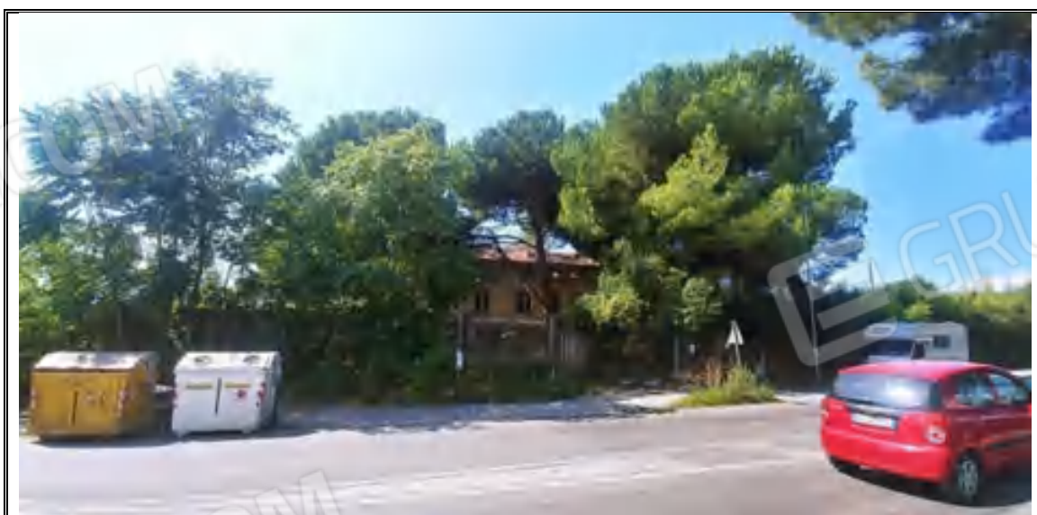
Foto n. 12 – Corpo A - Fabbricato mappale 282 – Vista del fabbricato dalla SS Aurelia
