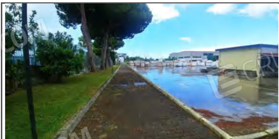
Foto n. 72 – Corpo C – Capannone mappale 547 – Vialeto e piazzale
