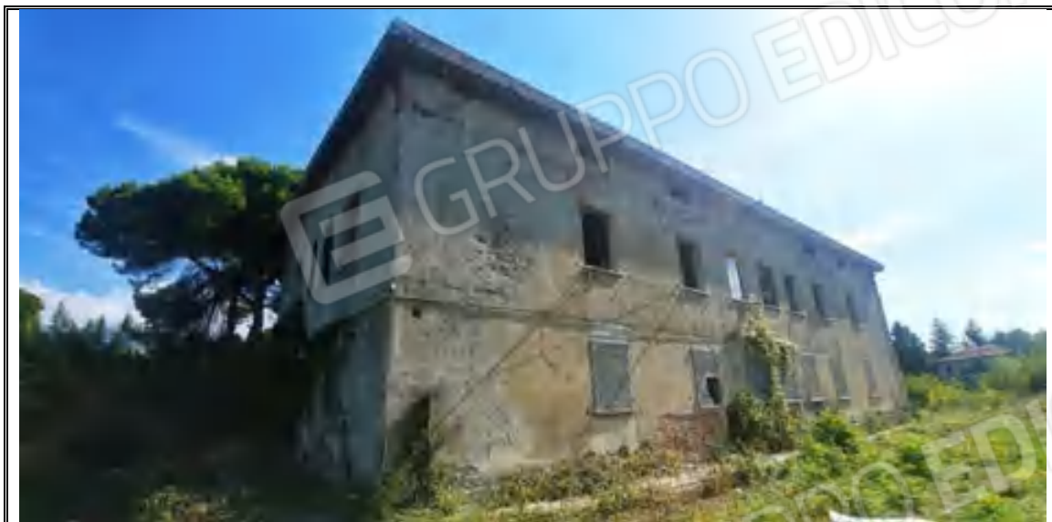
Foto n. 10– Corpo A - Fabbricato mappale 282 – Angolo OVEST
