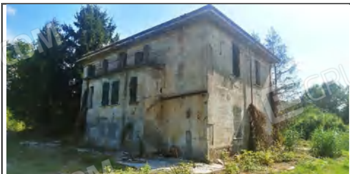
Foto n. 15 – Corpo A - Fabbricato mappale 287 – Angolo OVEST
