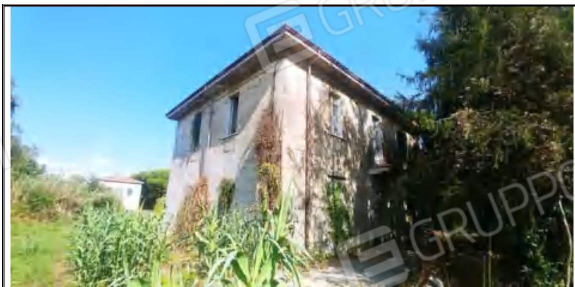
Foto n. 14 – Corpo A - Fabbricato mappale 287 – Angolo SUD
