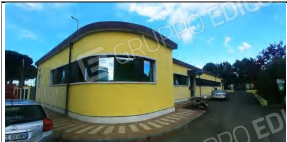
Foto n. 22– Corpo B – Palazzina uffici mappale 505 – Angolo EST
