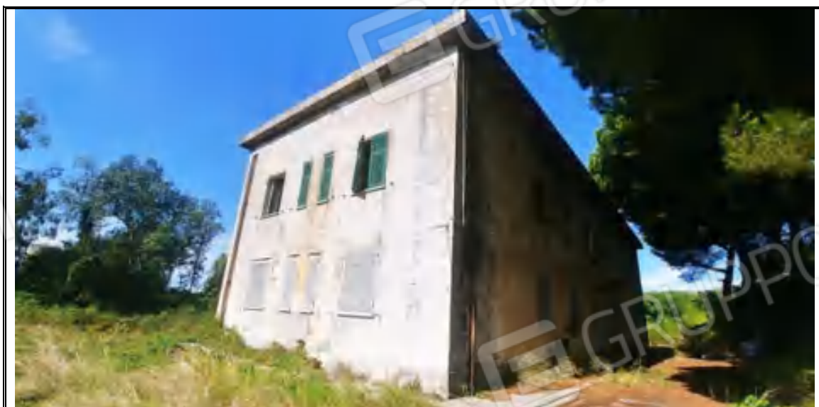
Foto n. 8 – Corpo A - Fabbricato mappale 282 – Angolo EST
