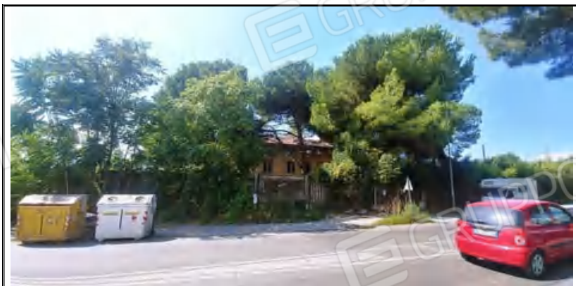
Foto n. 5 – Vista del compendio dalla SS Aurelia
