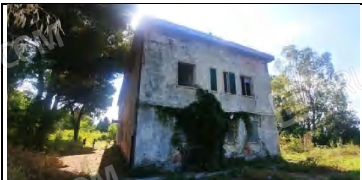
Foto n. 9 – Corpo A - Fabbricato mappale 282 – Angolo NORD
