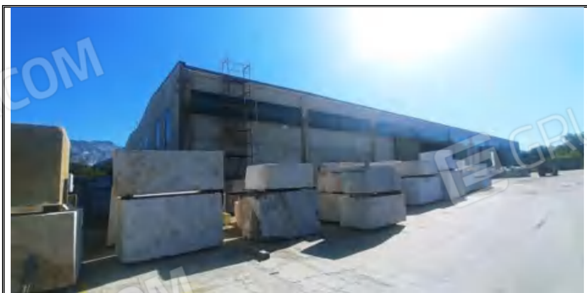
Foto n. 57 – Corpo C – Capannone mappale 547 – Angolo OVEST
