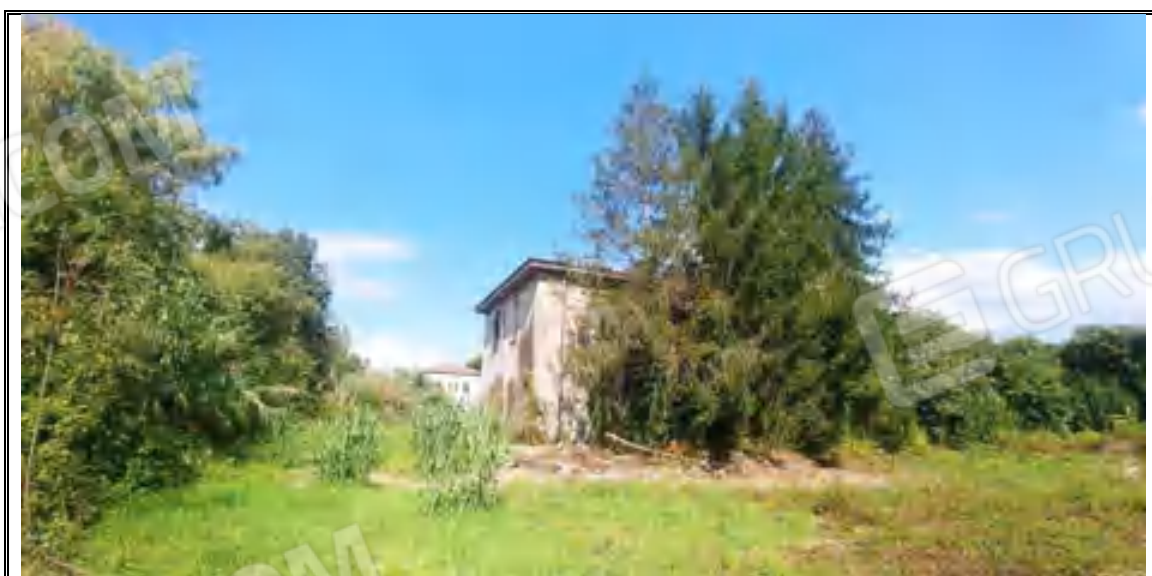
Foto n. 18 – Corpo A - Fabbricati mappali 282 e 287
