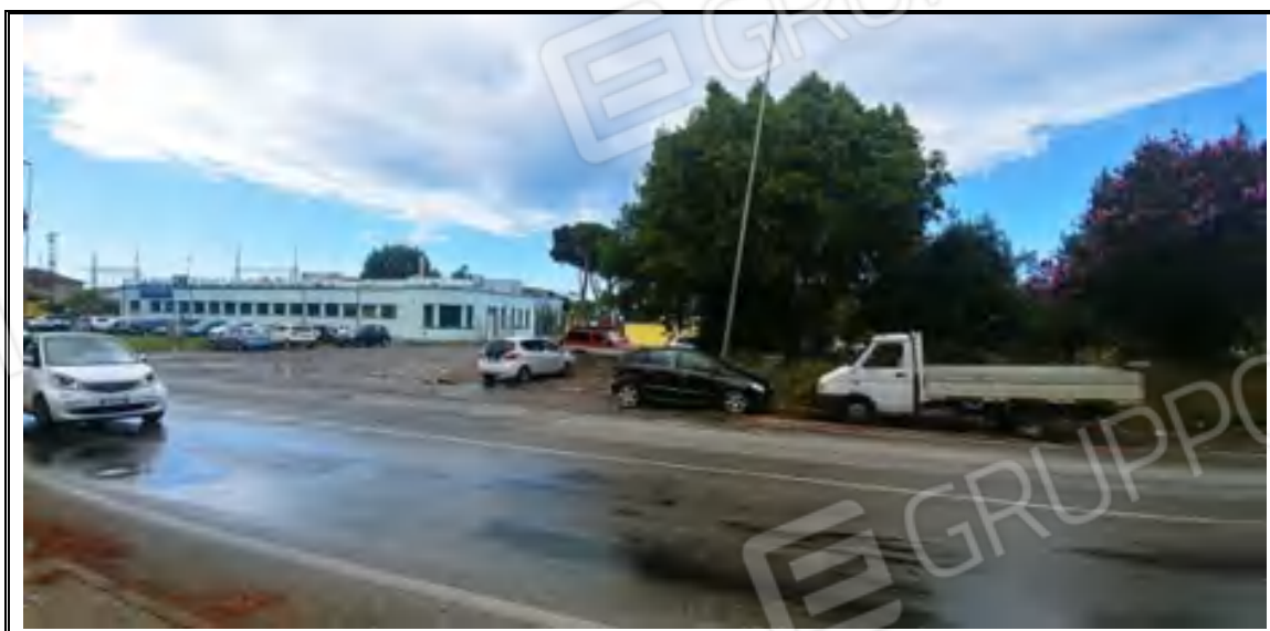
Foto n. 3 – Vista del compendio dalla SS Aurelia
