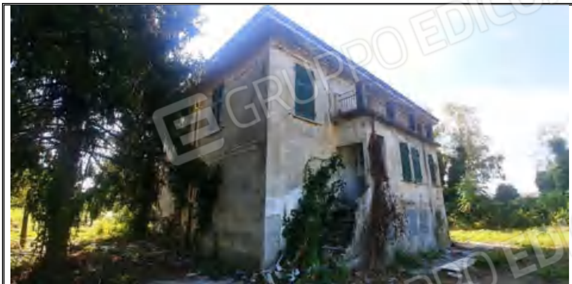
Foto n. 16– Corpo A - Fabbricato mappale 287 – Angolo NORD
