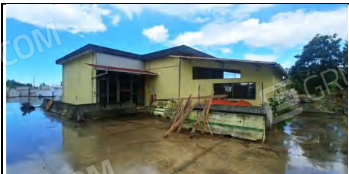
Foto n. 51 – Corpo C – Magazzino mappale 548 – Angolo EST
