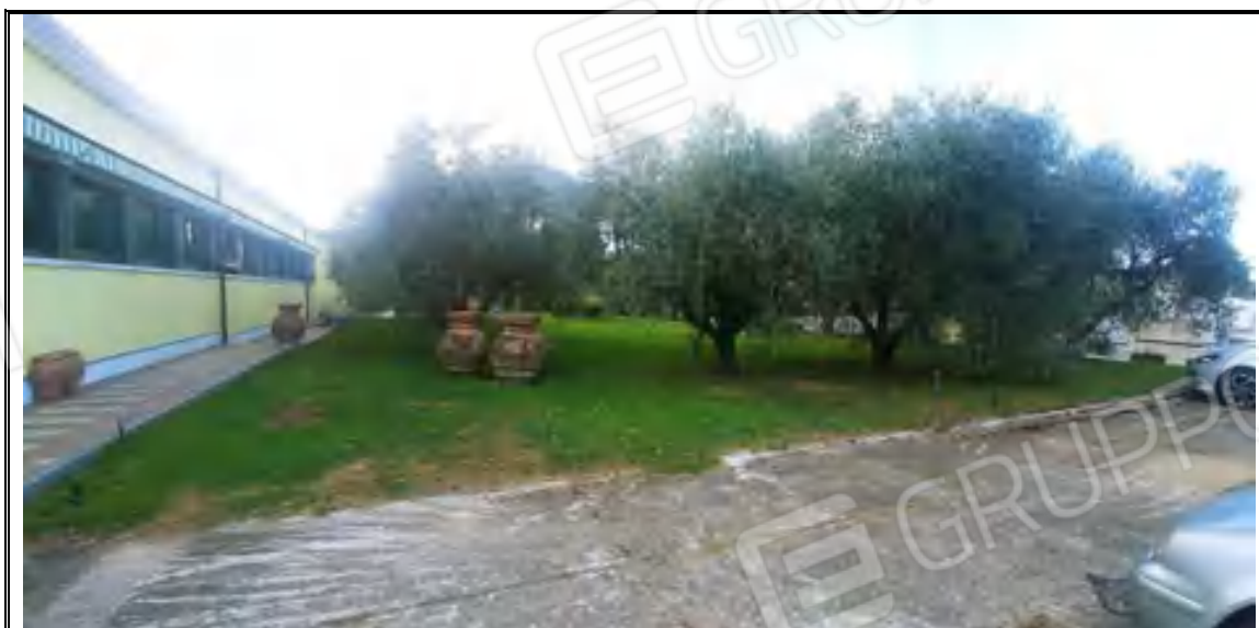
Foto n. 26– Corpo B – Palazzina uffici mappale 505 – Terreno pertinenziale
