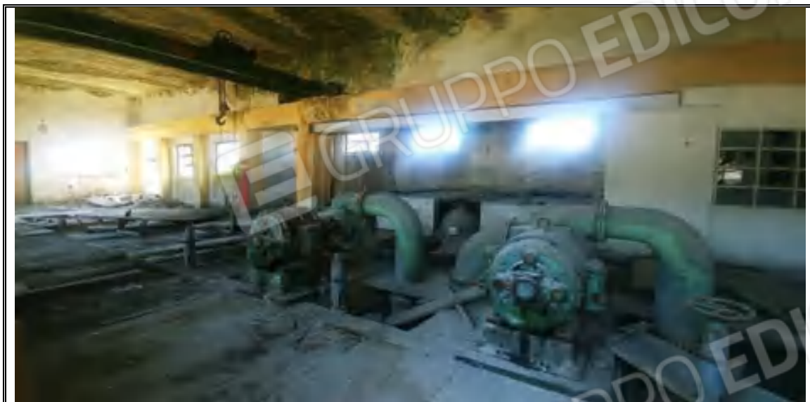
Foto n. 79 – Corpo D – Ex stazione pompaggio mappale 470 – Interno
