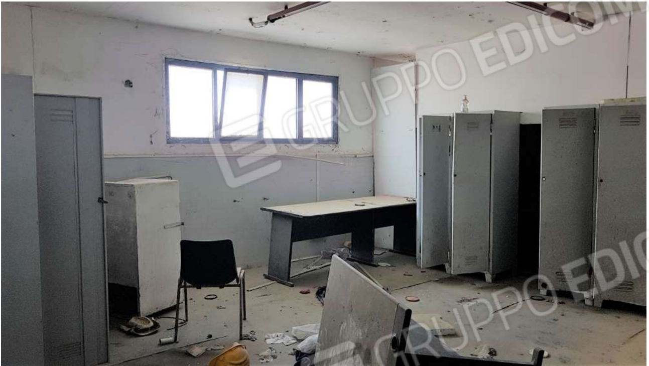
FOTO 7 vista interna zona spogliatoi
