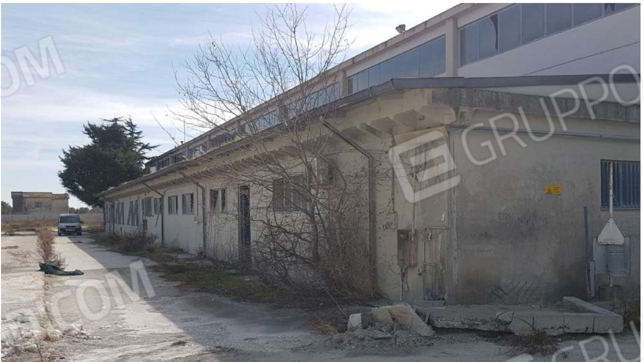
FOTO 4 vista area mensa e uffici annessa al capannone (fg. 15-p.Ila 204-sub.3)
