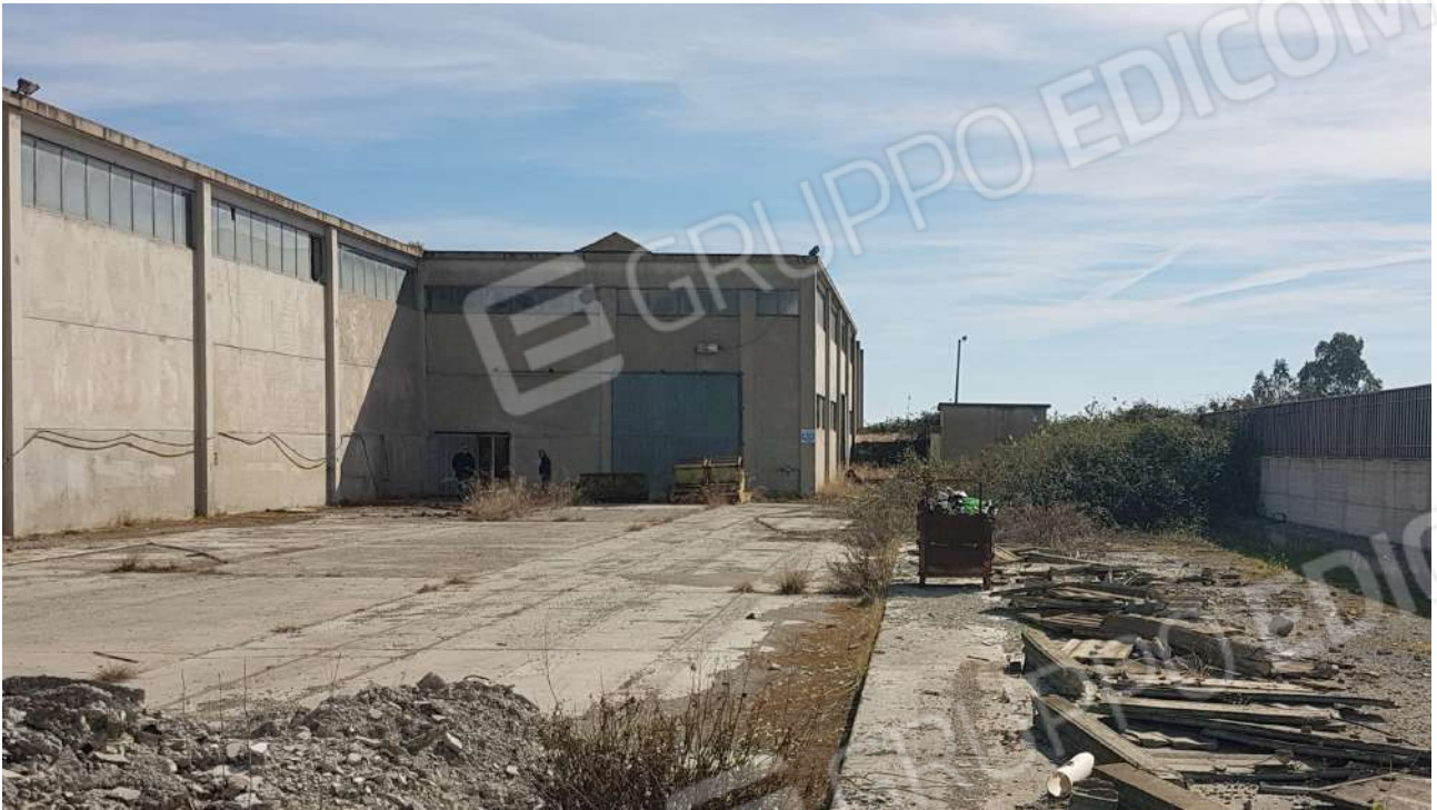
FOTO 3 vista piazzale capannone sud ovest (fg. 15-p.Ila 204-sub.3)
