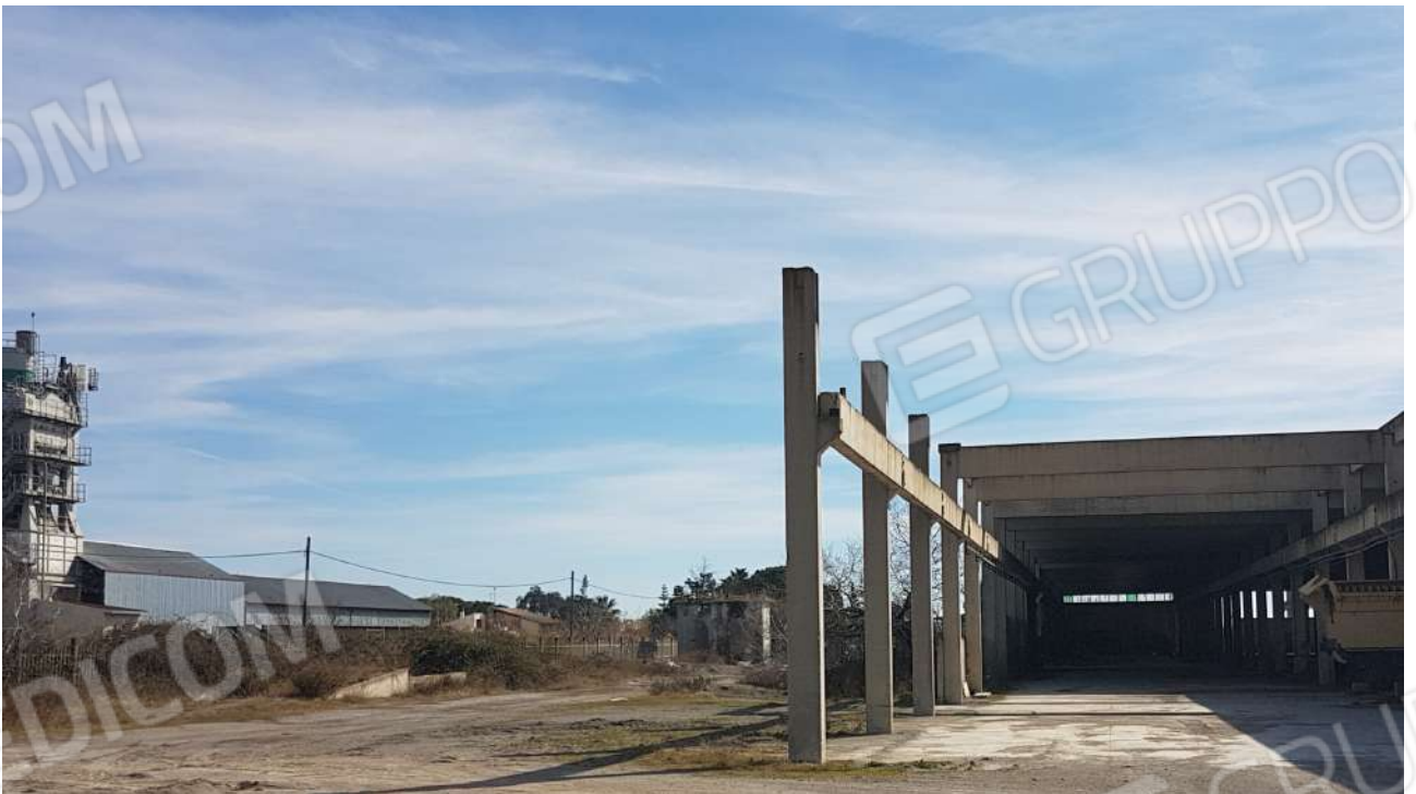
FOTO 12 vista tettoia (fg. 15-p.Ila 204-sub.5) da S.S. 106
