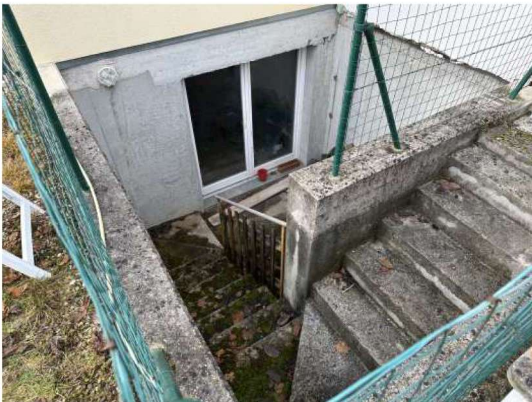
Foto 09: scale scoperte per l'accesso esterno al Piano Interrato
