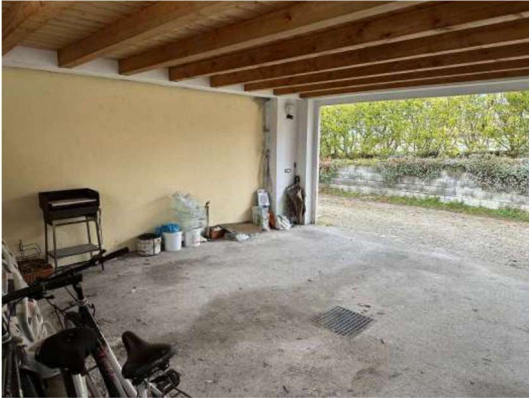
Foto 23: PT (sub. 3) – garage
