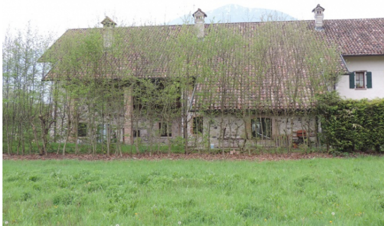
Lato Nord (sub 3)
