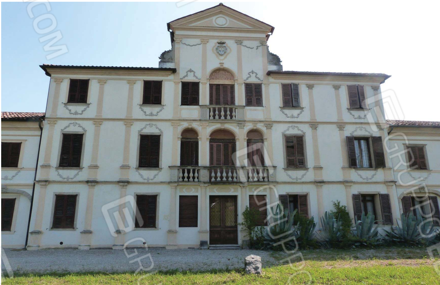
Vista del corpo centrale – prospetto principale.
