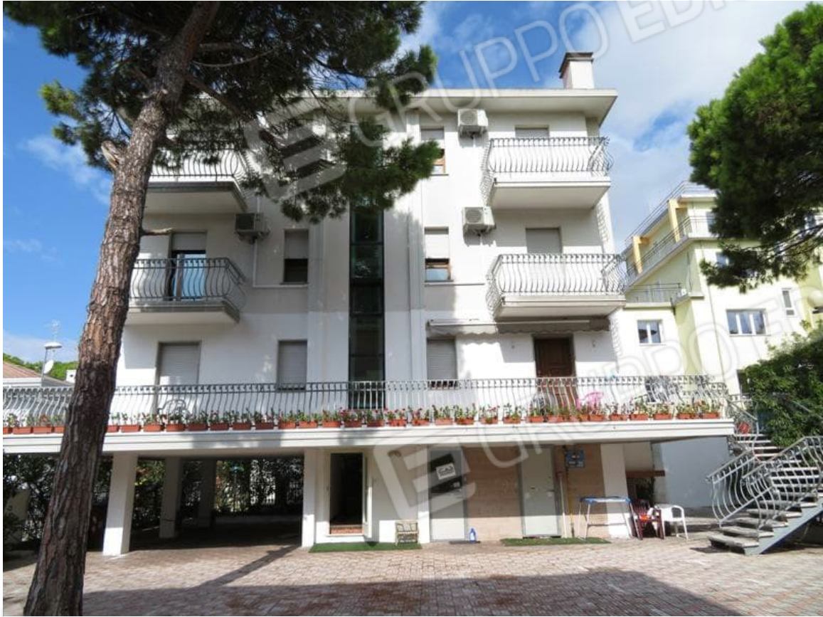
Vista del fabbricato prospetto sud.
