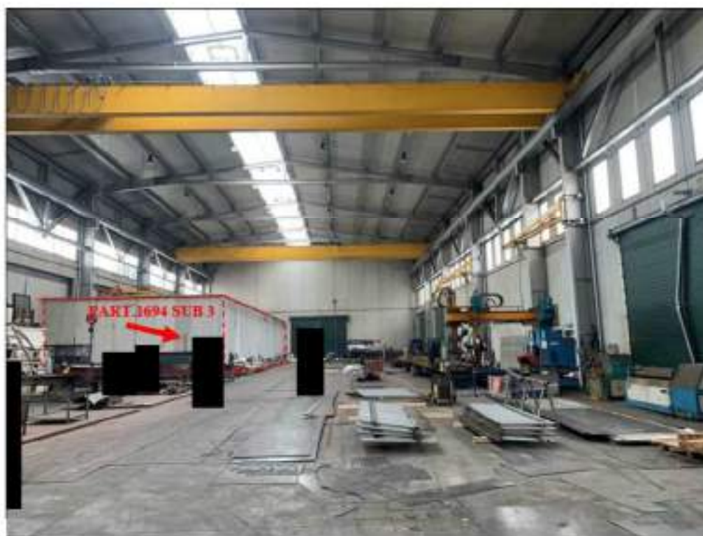
FIG. 14 - VISTA INTERNA PART.1694.SUB.4 IN LOCAZIONE ALLA SOCIETA' [REDACTED] E IMMOBILE IDENTIFICATO CON LA PART. 1694 SUB 3 IN LOCAZIONE ALLA [REDACTED]
