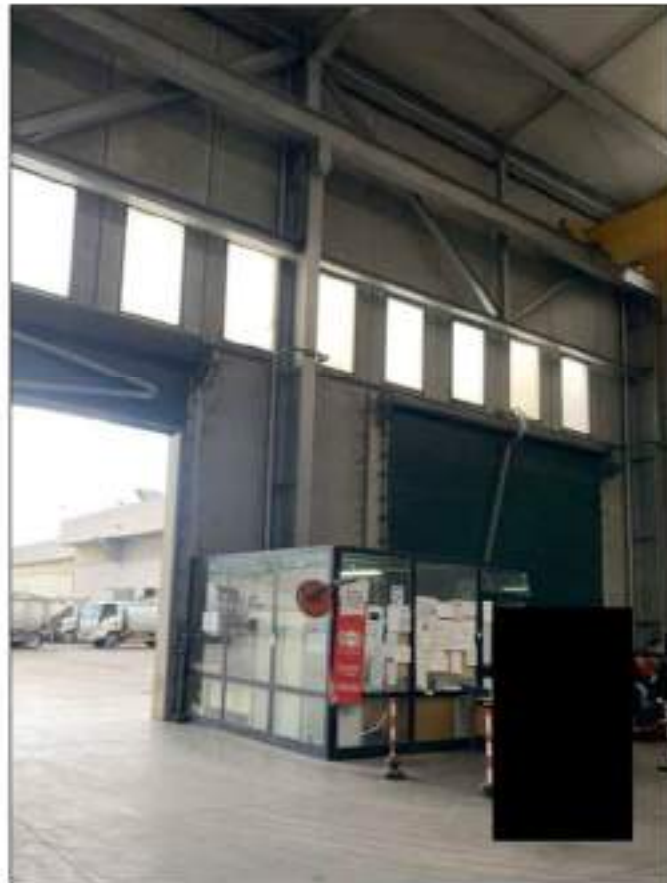
FIG. 26 – VISTA INTERNA – INGRESSO CAPANNONE PART.1694 SUB 4 IN LOCAZIONE ALLA [REDACTED]
