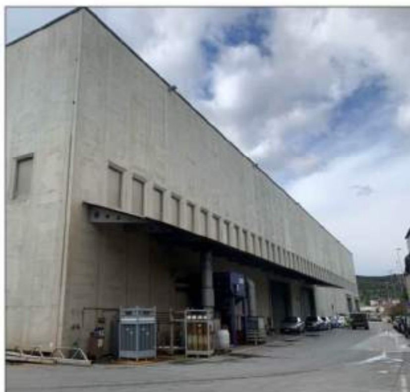
FIG. 12 - CAPANNONE PART.1694 - VISTA LATERALE (NORD)
