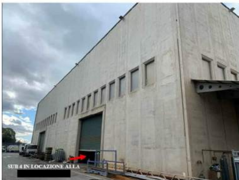
FIG. 13 - CAPANNONE PART.1694 - VISTA POSTERIORE (EST)
