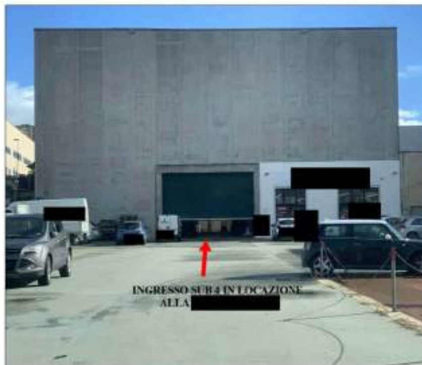
FIG. 11 - CAPANNONE PART.1694 - INGRESSO PRINCIPALE (OVEST)
