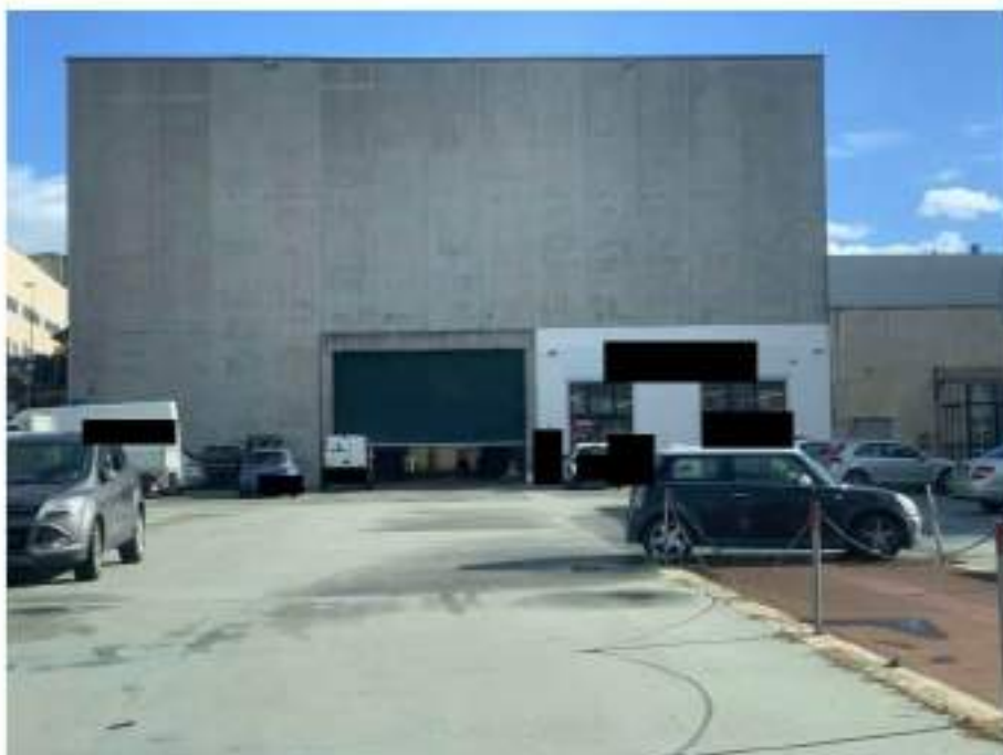
FIG. 31- CAPANNONE PART.1694 - INGRESSO PRINCIPALE LOCALE ██████████ (OVEST)
