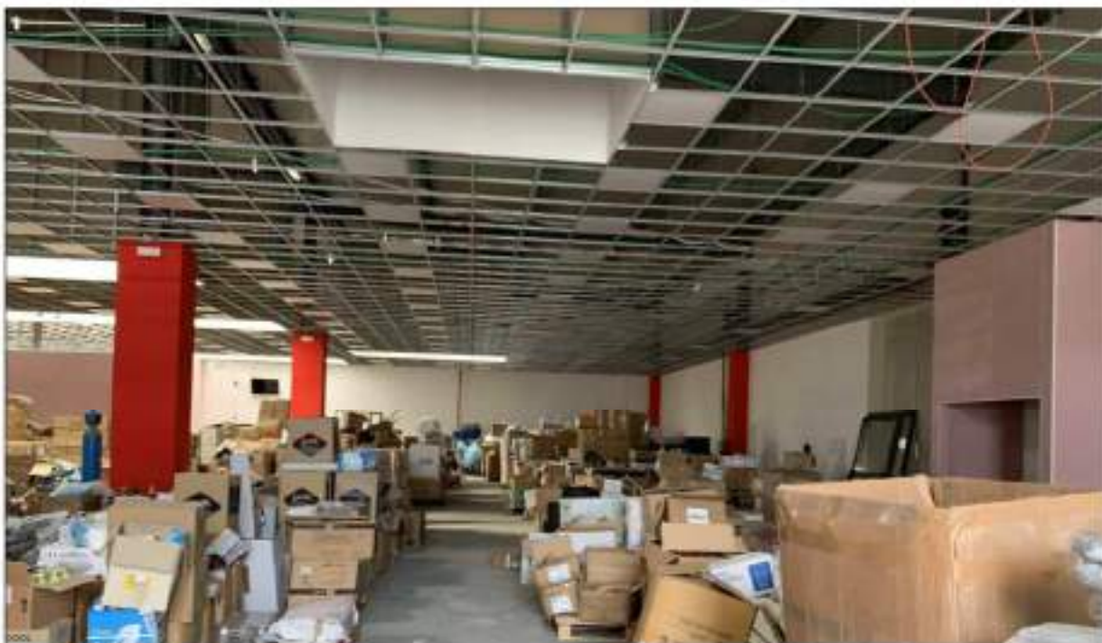
FIG. 49 - VISTA INTERNA PART 1473 SUB 4 PORZIONE DESTINATA AD ATTIVITA' COMMERCIALE
