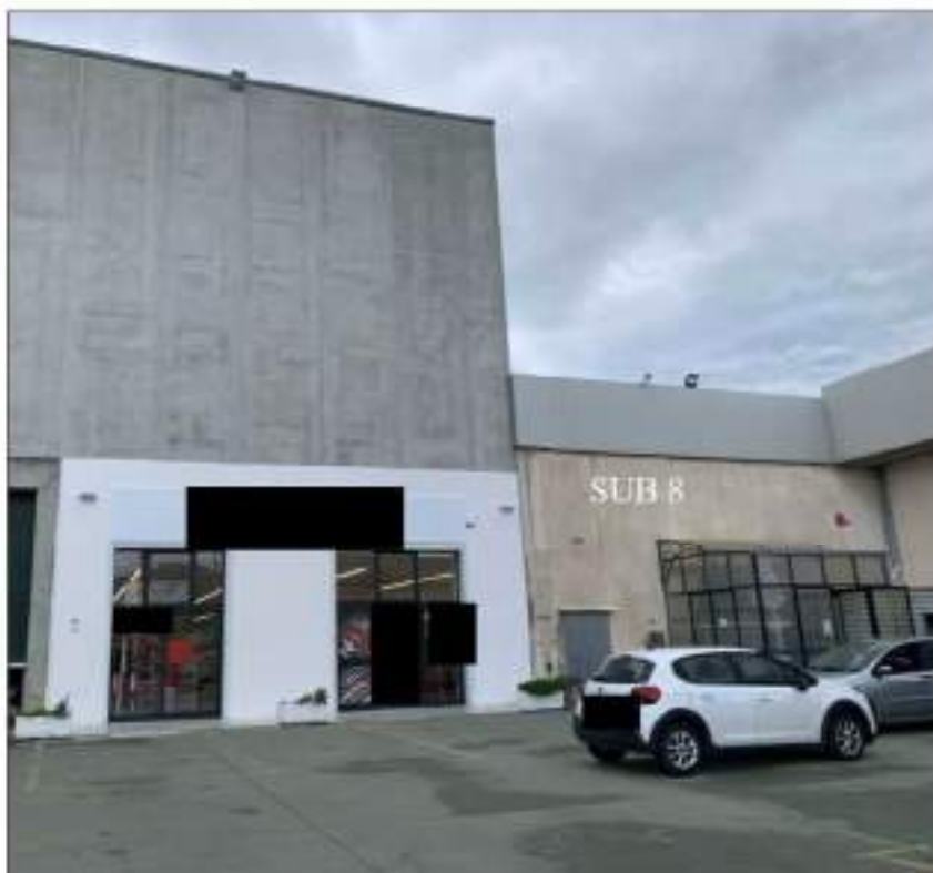
FIG. 35 - INGRESSO PORZIONE CAPANNONE PART.1473 SUB 8 IN LOCAZIONE A [REDACTED]
