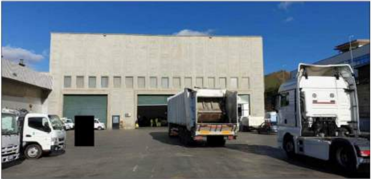
FIG. 22 – VISTA INGRESSO CAPANNONE PART.1694 SUB 4 - PORZIONE IN LOCAZIONE ALLA [REDACTED]
