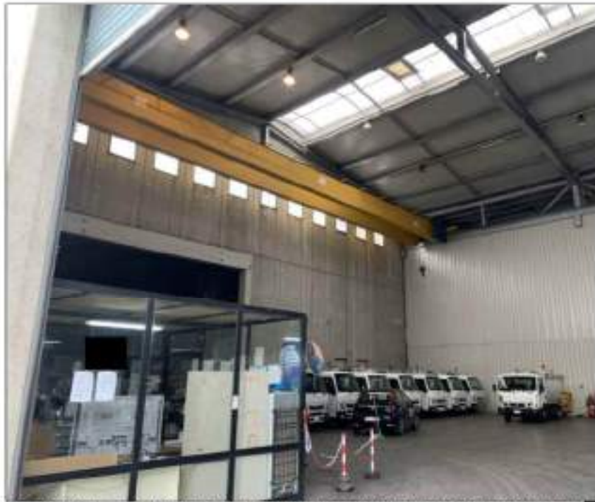
FIG. 27 – VISTA INTERNA – INGRESSO CAPANNONE PART.1694 SUB 4 IN LOCAZIONE ALLA [REDACTED]
