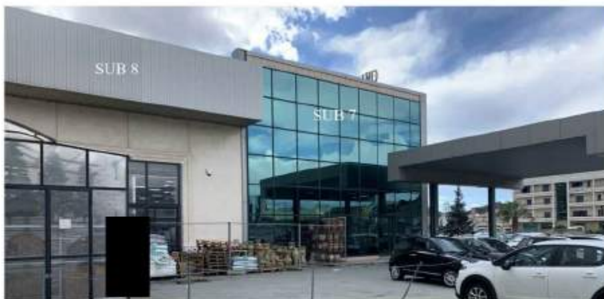
FIG. 37 - VISTA PORZIONE CAPANNONE PART.1473 SUB 8 E SUB 7 IN LOCAZIONE A [REDACTED]
