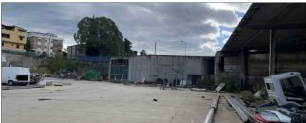
FIG. 55 - FABBRICATO PART 1544 SUB 1
