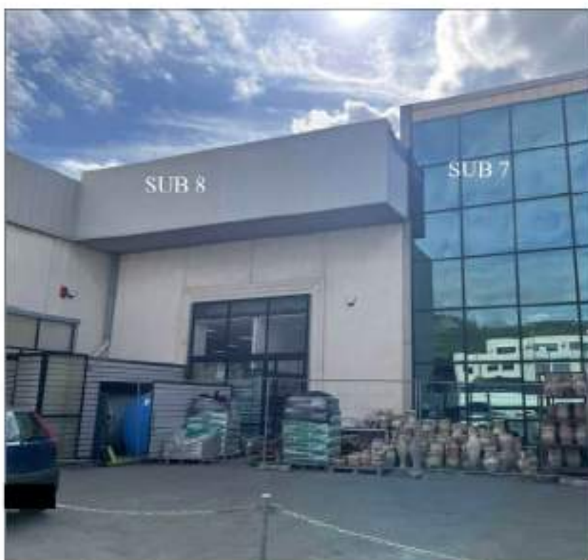
FIG. 36 - INGRESSO PORZIONE CAPANNONE PART.1473 SUB 8 IN LOCAZIONE A [REDACTED]
