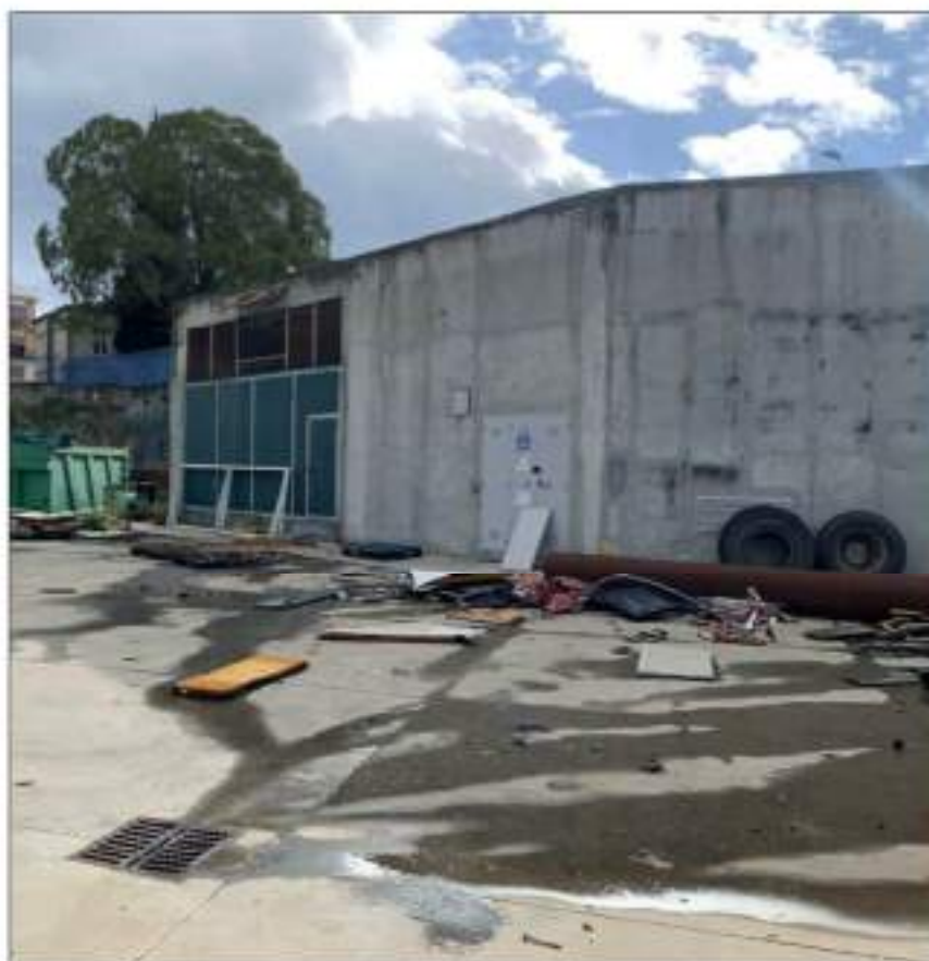
FIG. 56 - FABBRICATO PART 1544 SUB 1
