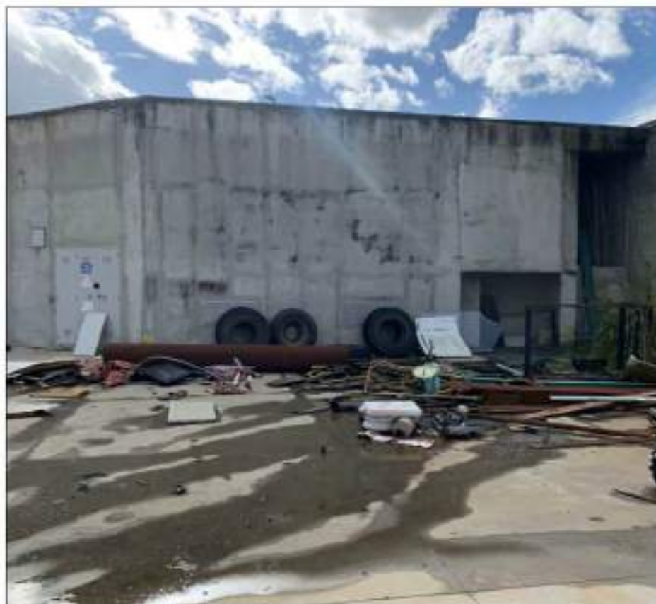
FIG. 57 - FABBRICATO PART 1544 SUB 1
