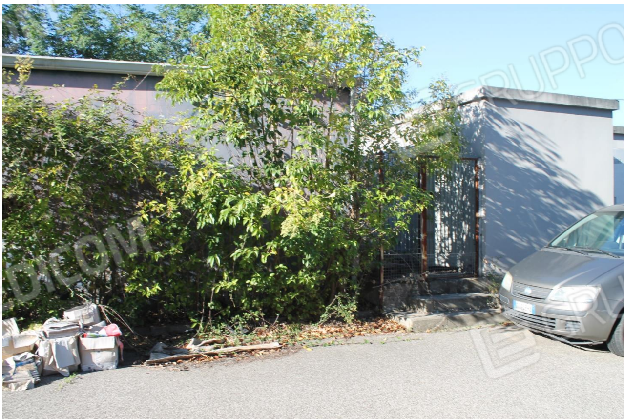
Foto n.26 – locali tecnici (p.lla 363)
