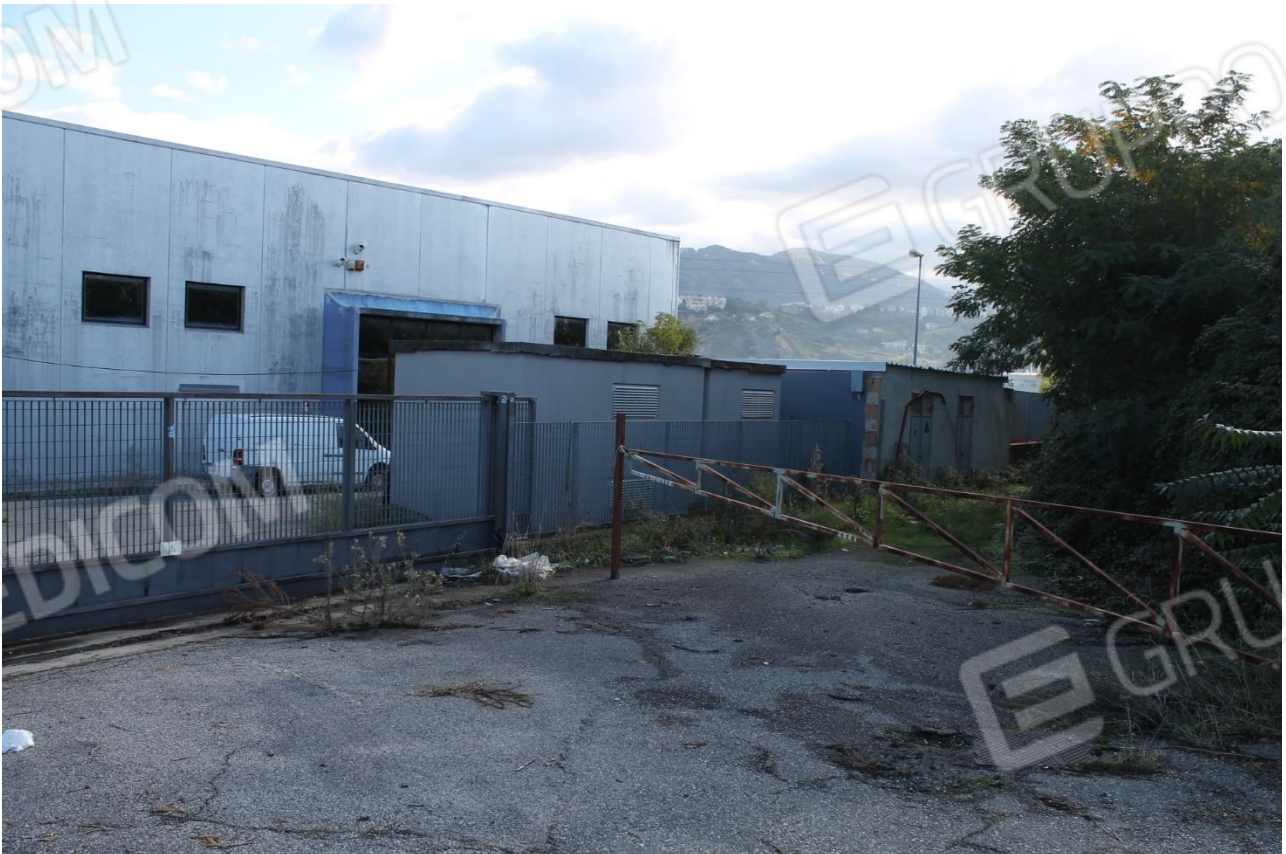
Foto n.28 – locali tecnici (p.la 498-499-363) vista dall'esterno della recinzione
