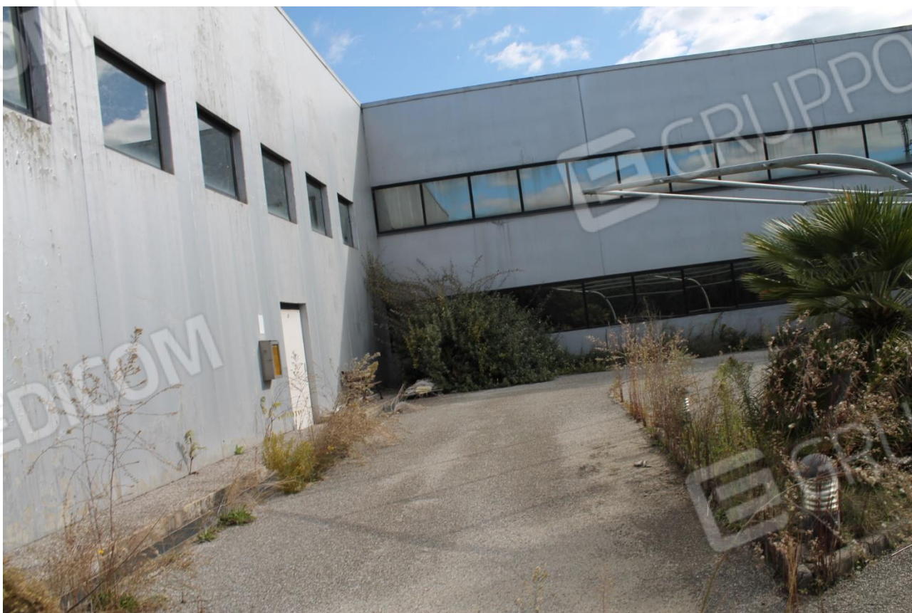
Foto n.18 – corpo uffici (p.lla 347 sub. 3) – prospetto laterale
