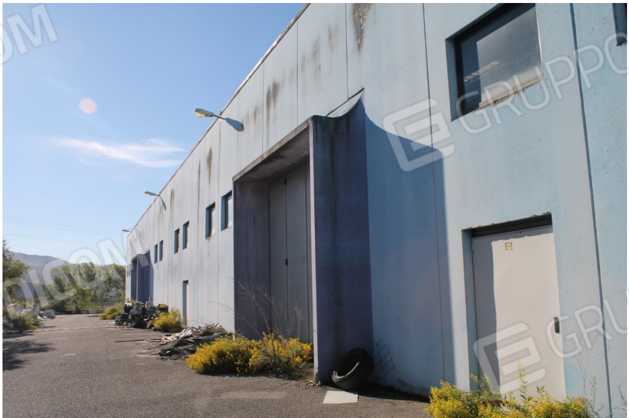
Foto n.2 – Capannone (p.Ila 346) - - ingresso vista posteriore
