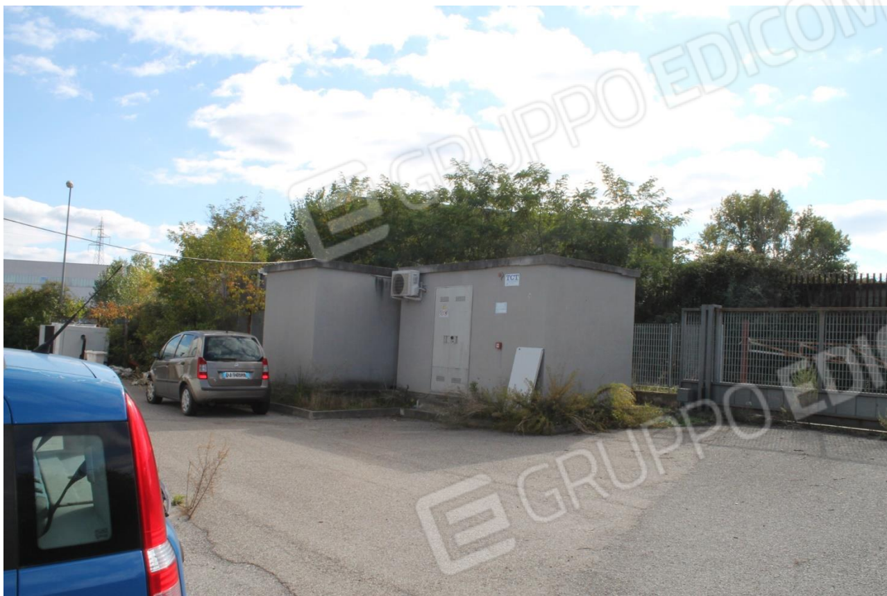
Foto n.25 – locali tecnici (p.lla 498-499)
