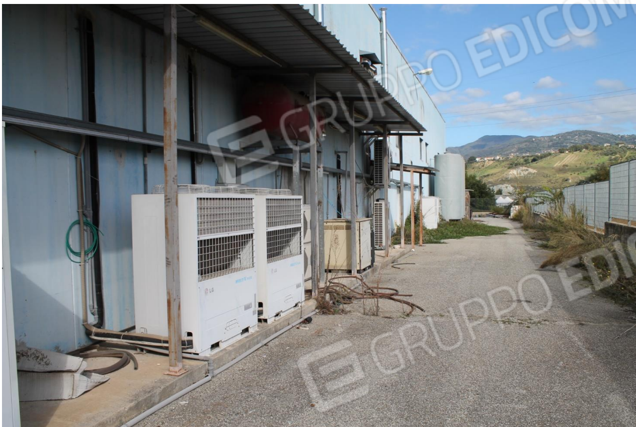
Foto n.17 – corpo uffici (p.lla 347 sub. 3) – lato posteriore
