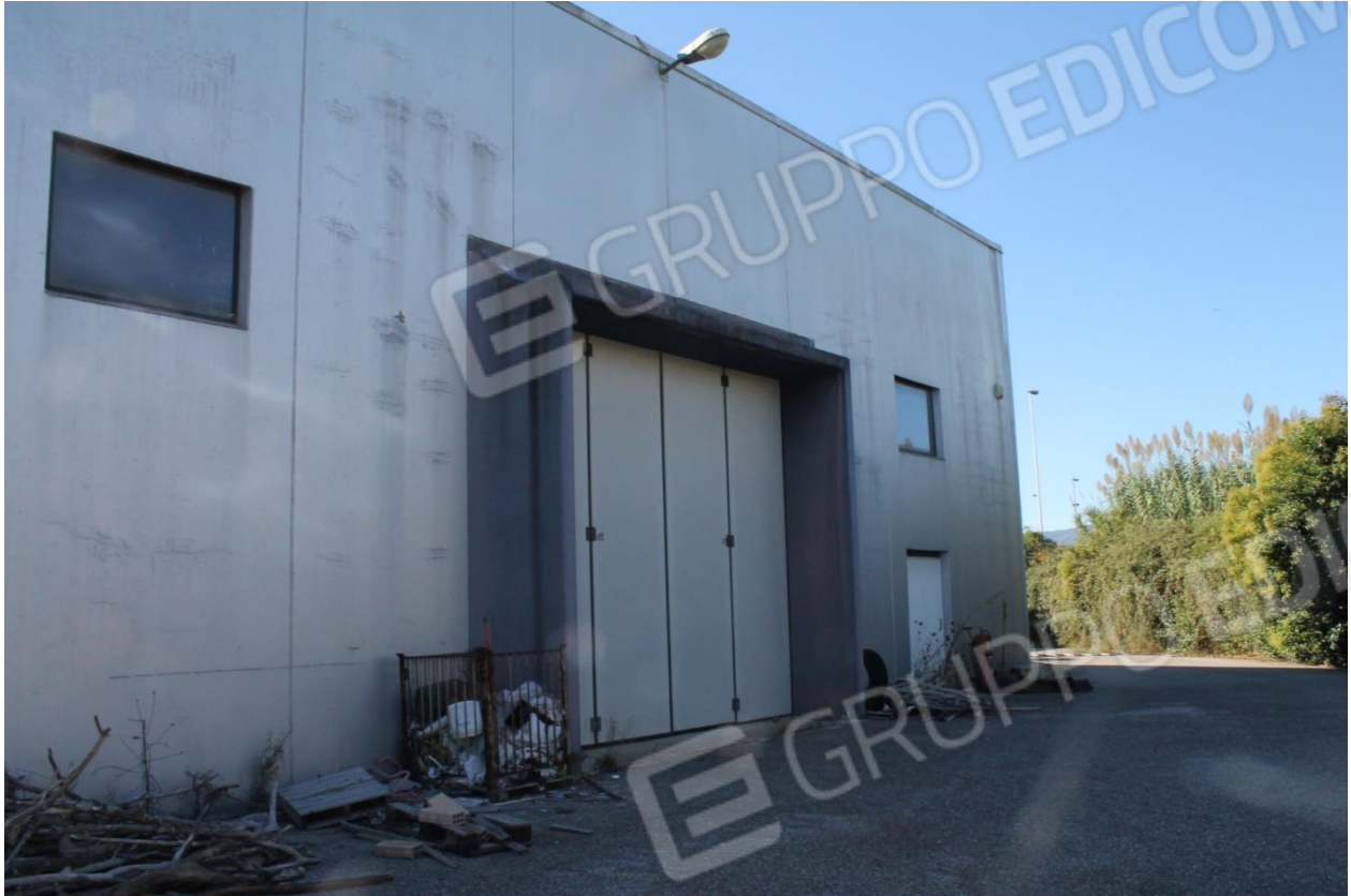
Foto n.1 – Capannone (p.Ila 346) – ingresso vista laterale
