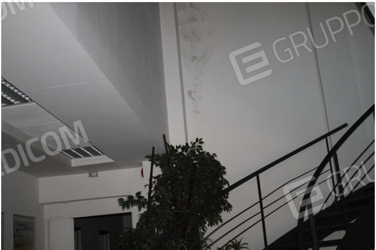
Foto n.20 – corpo uffici (p.la 347 sub. 3) – accettazione
