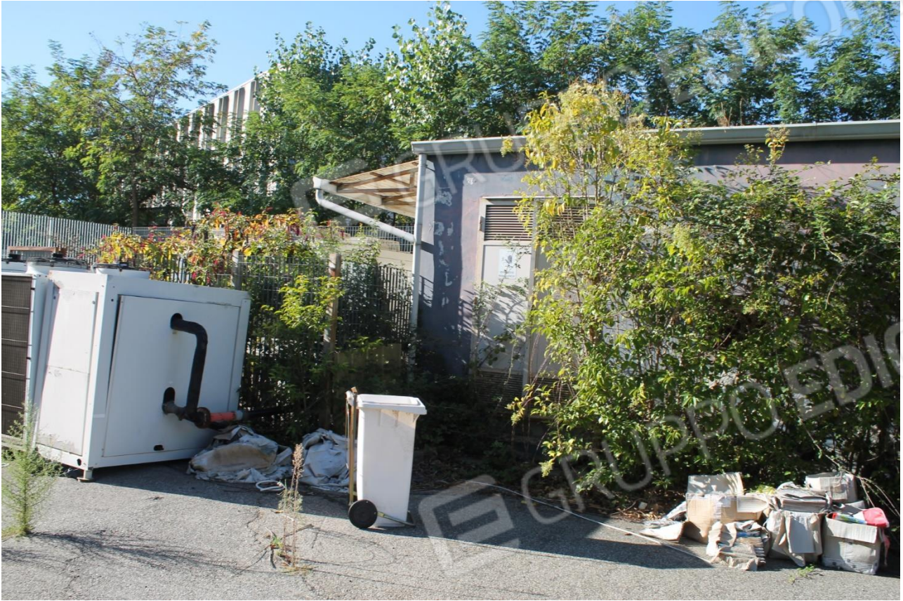
Foto n.27 – locali tecnici (p.la 363)
