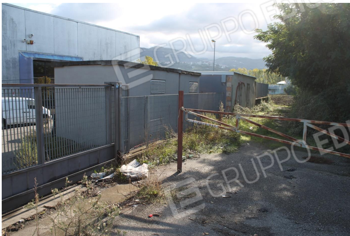
Foto n.29 – locali tecnici (p.la 498-499-363) vista dall'esterno della recinzione e stradella con servitù
