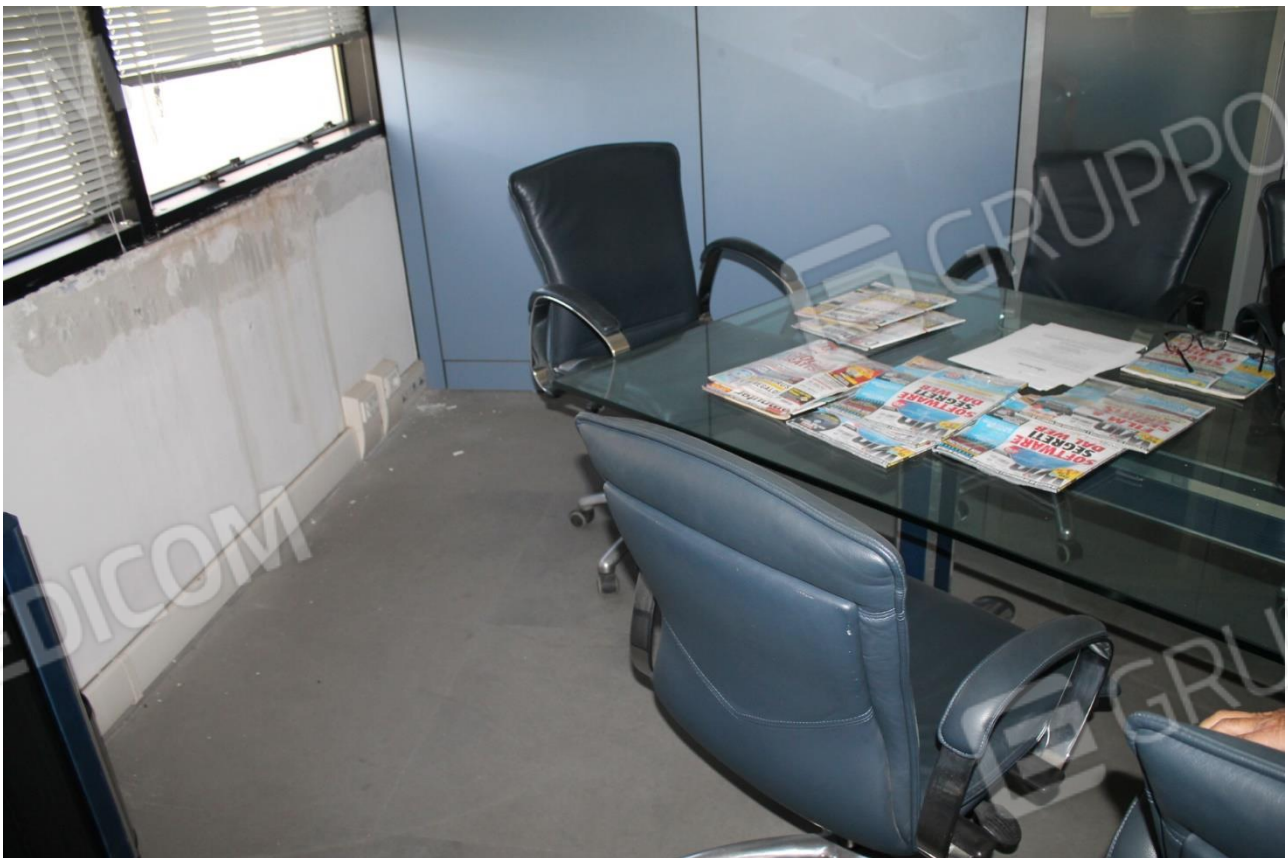
Foto n.22 – corpo uffici (p.la 347 sub. 3) – locali uffici
