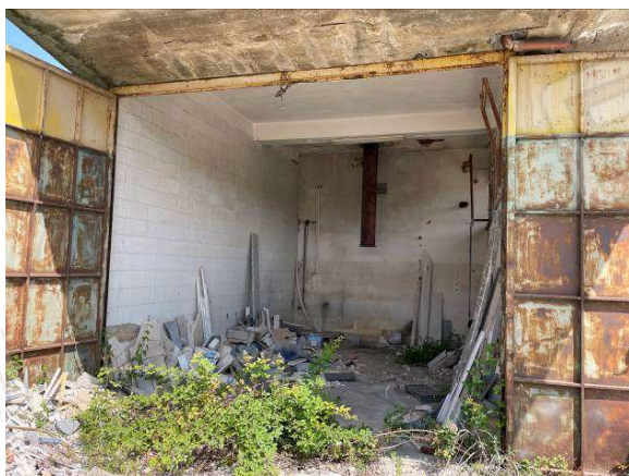
FOTO 3 – locale ex centrale termica
