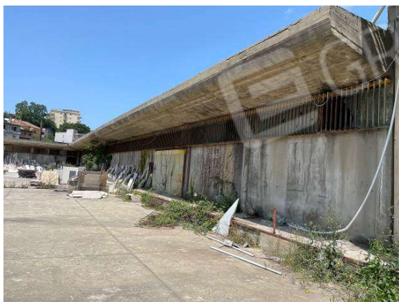
FOTO 1 – prospetto del piano terra
