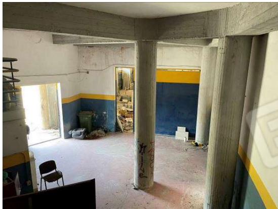
Foto 21 – androne di accesso
