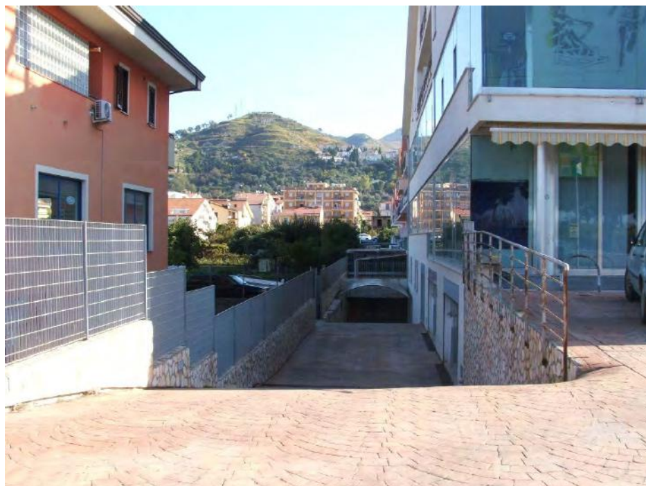
Foto n° 6 – Ingresso carrabile lato nord
