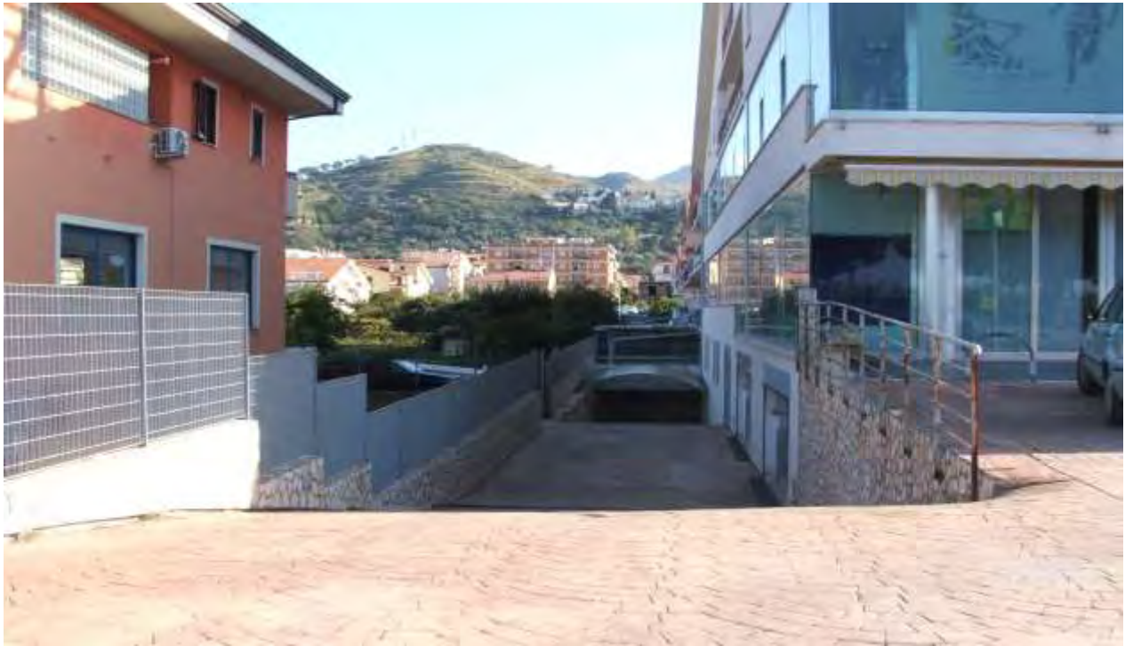
Percorso carrabile a nord -sub 12 -che conduce ai piani primo e secondo interrato. Vista da via stromboli.
