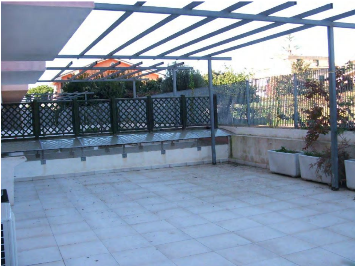
Foto n° 18 – Terrazzino appartenente ad unità immobiliare
