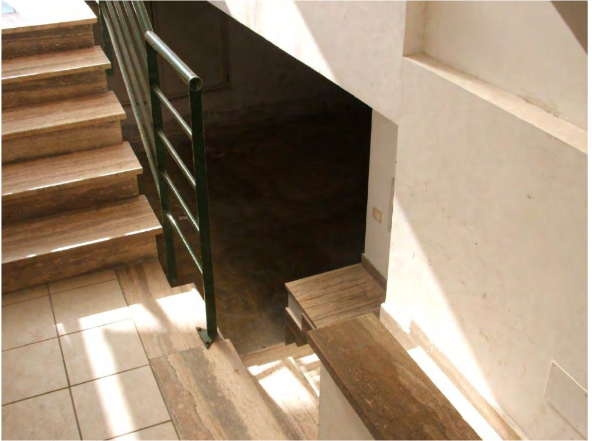
Foto n° 19 – Accesso al piano interrato
