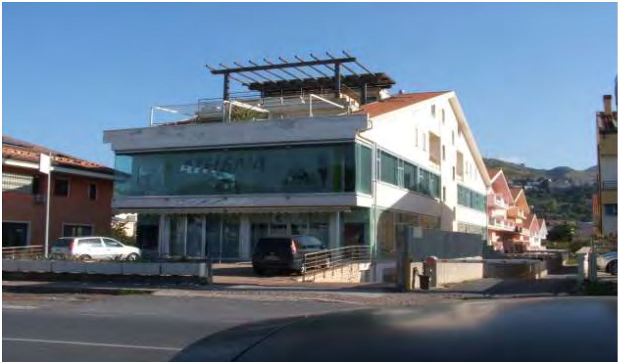
Vista del complesso edilizio da via Stromboli- ovest (Strada Statale n° 18).
