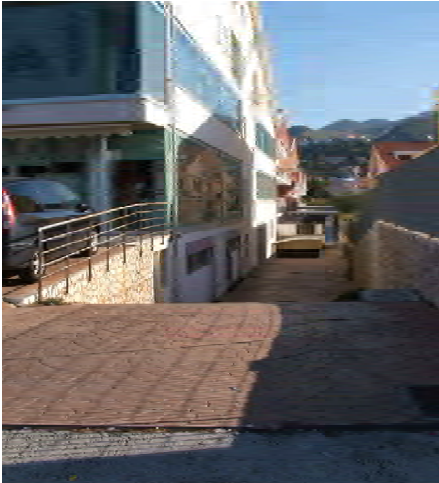
Foto n° 3 – Prospetto sud- Vista percorso carrabile
