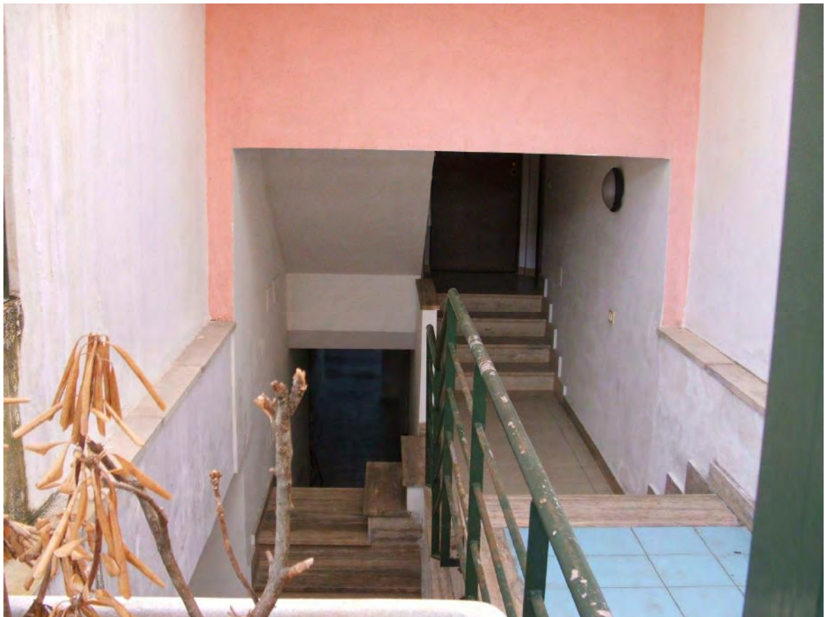
Foto n° 8 – Vano scala di accesso all'interrato
