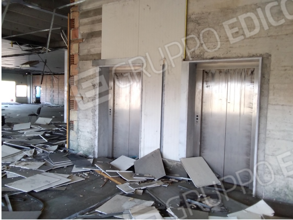
BLOCCO ASCENSORI –PIANO PRIMO
