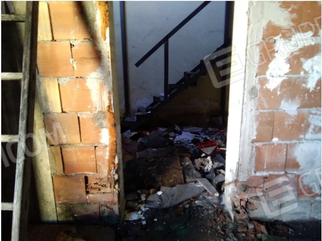
VANO SCALA DI COLLEGAMENTO AL SOPPALCO
