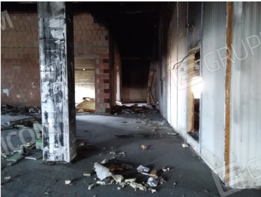
INTERNO OPIFICIO – PIANO TERRA
