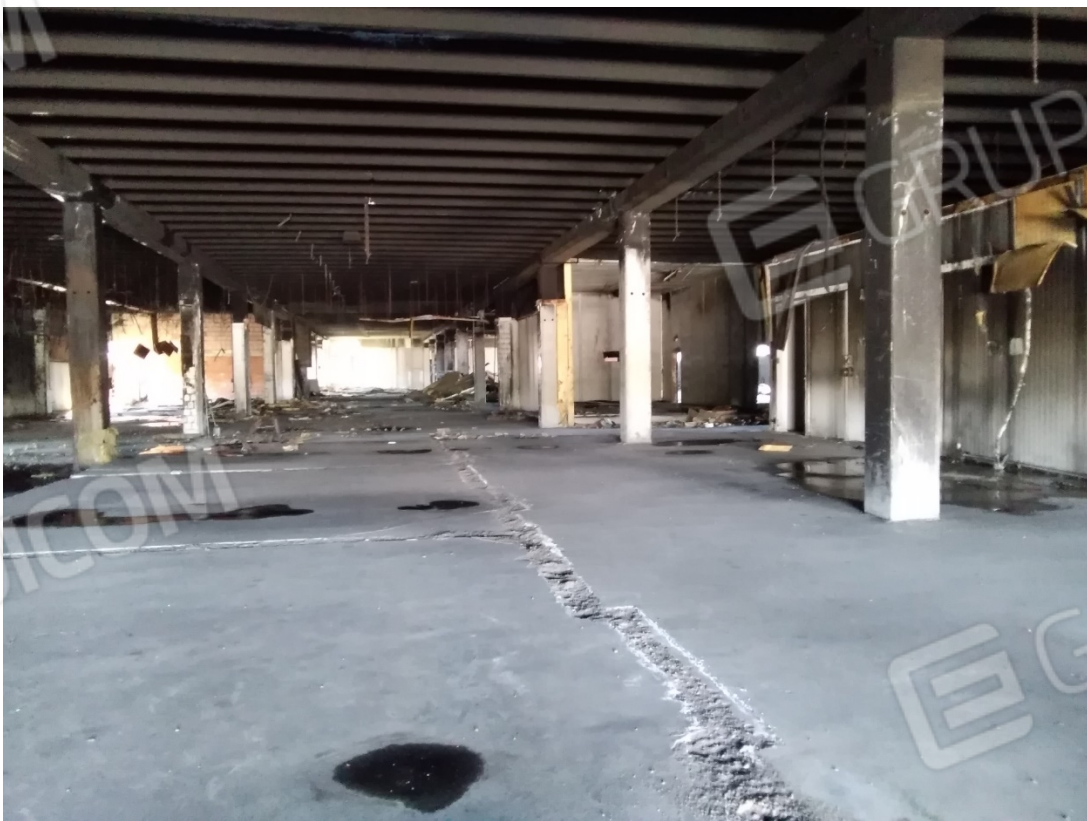
INTERNO OPIFICIO – PIANO TERRA
