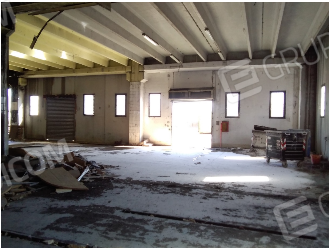
INTERNO OPIFICIO – PIANO TERRA
