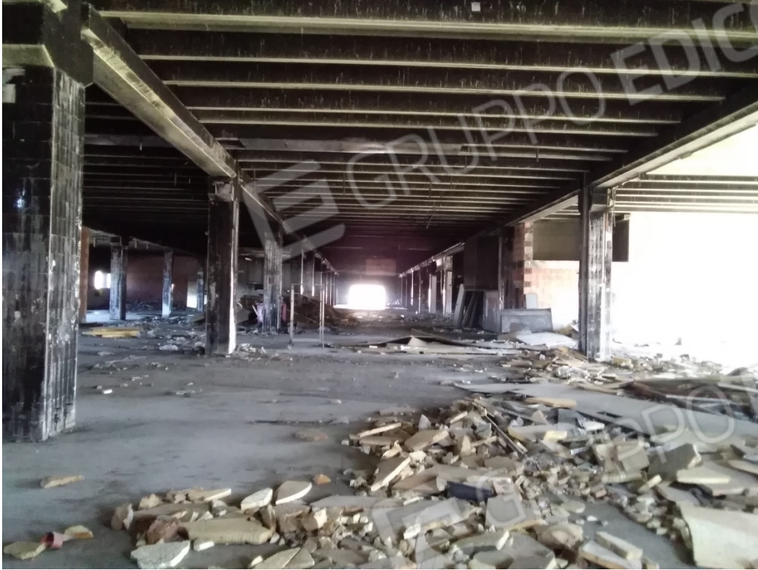
INTERNO OPIFICIO – PIANO TERRA
