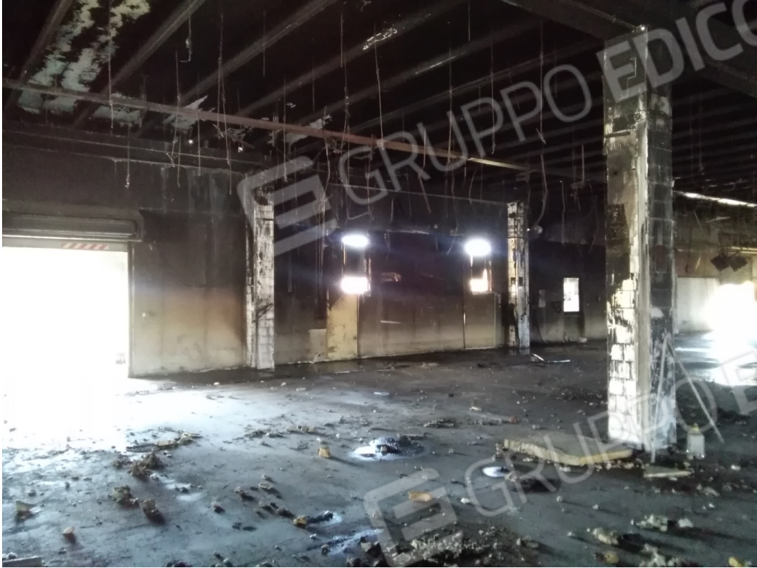
INTERNO OPIFICIO – PIANO TERRA
