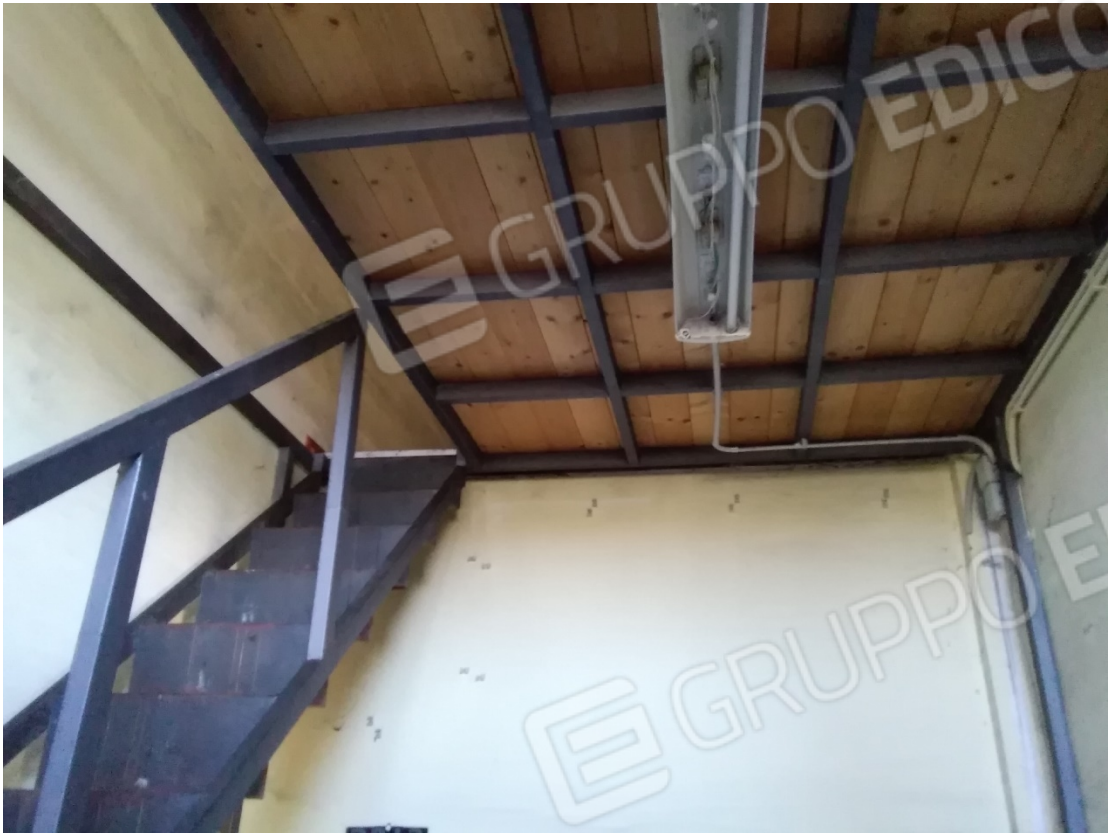
SCALA DI COLLEGAMENTO AL SOPPALCO
