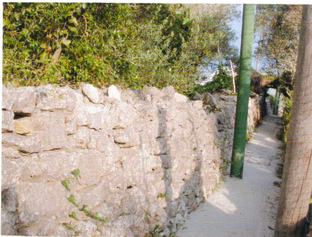
VISTA DA MONTE A VALLE
