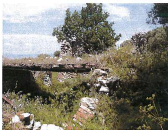
Foto 45 e 46: l'altro manufatto diruto: i resti del solaio intermedio e dei cantonali
