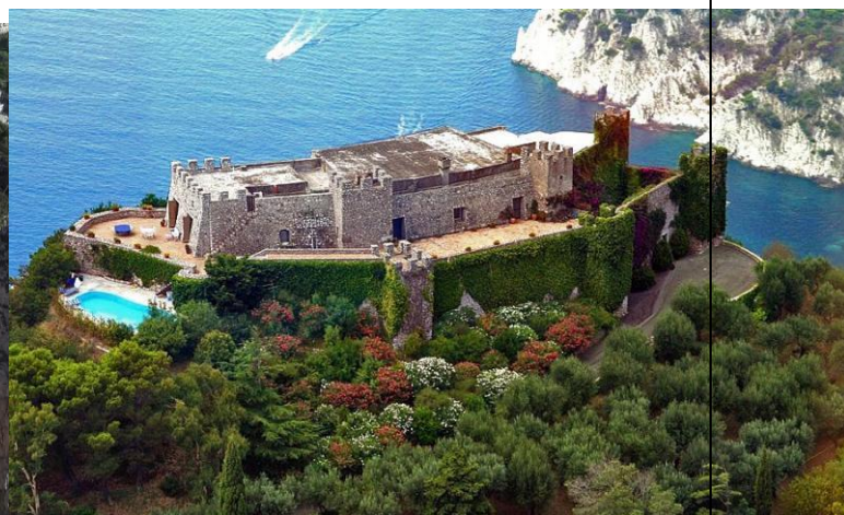
Vista aerea Villa Castiglione
