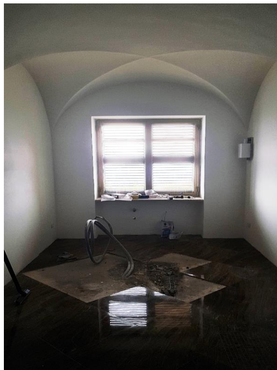
Vista locali bagno – rifacimento totale impianti
