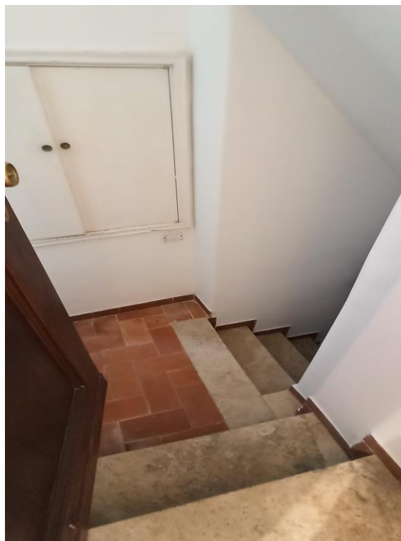
Vista scale di accesso al piano seminterrato
