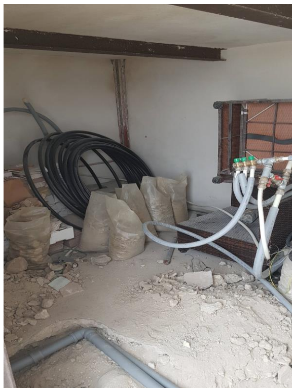
Vista lavori di rifacimento impianti idrici e di condizionamento interni alla struttura
