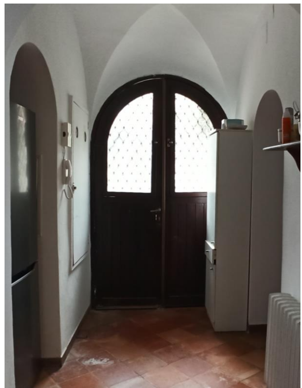
Vista portoncino di accesso al piano seminterrato
