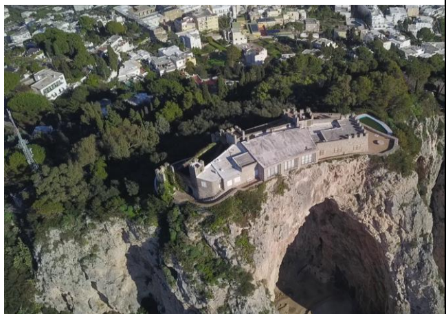
Vista aerea Villa Castiglione
