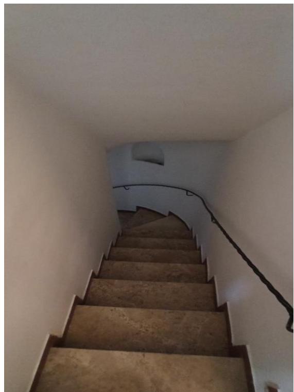
Vista scale di accesso al piano seminterrato
