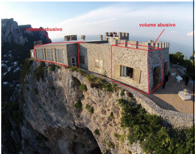
Vista aerea Villa Castiglione
