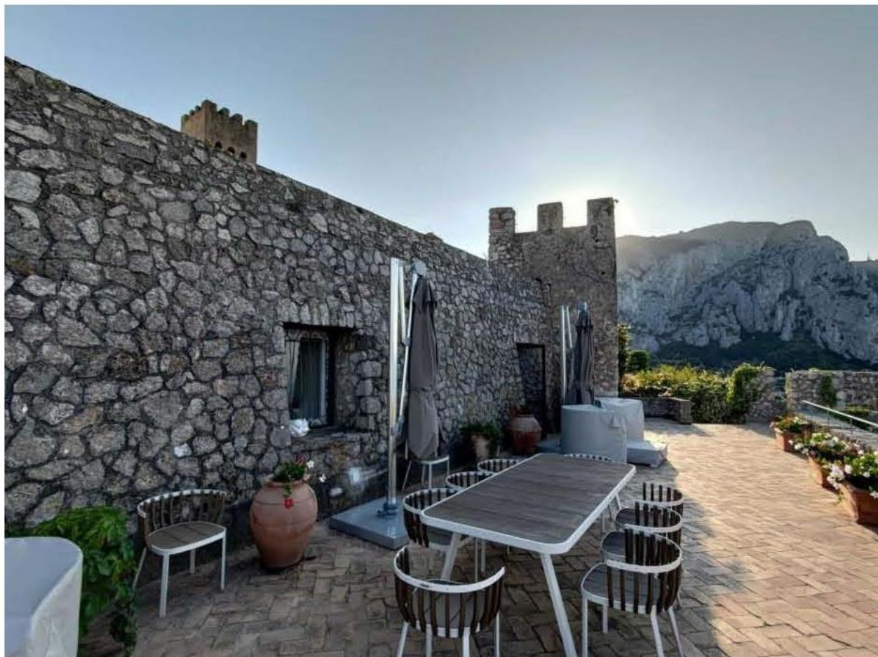
Vista cortina muraria interna
