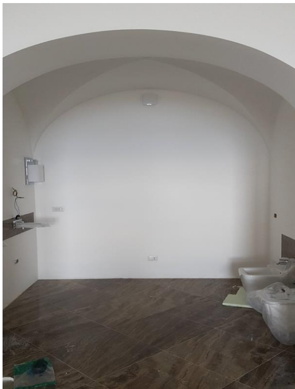
Vista locali bagno – rifacimento totale impianti
