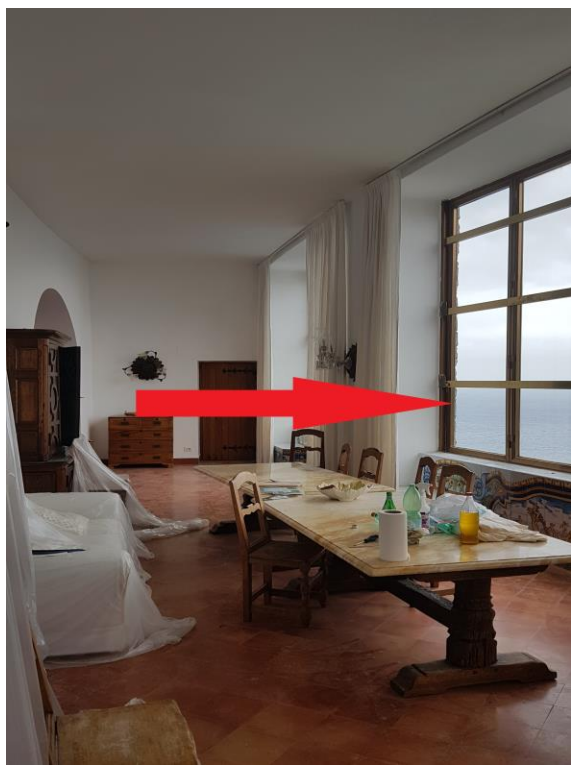
Vista infissi sostituiti nel corso dei sopralluoghi
