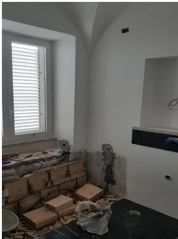
Vista opere di muratura in corso di lavorazione
