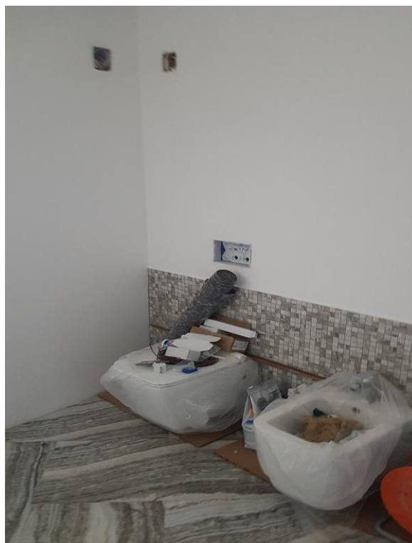
Vista locali bagno – rifacimento totale impianti
