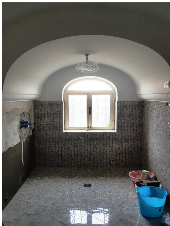
Vista locali bagno – rifacimento totale impianti
