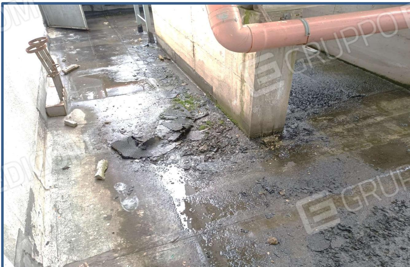
Foto 33 stato delle guaine di impermeabilizzazione
