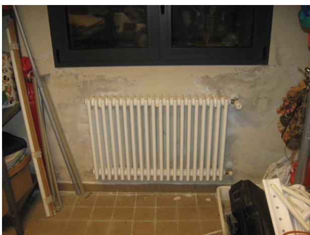
cantina e centrale termica
