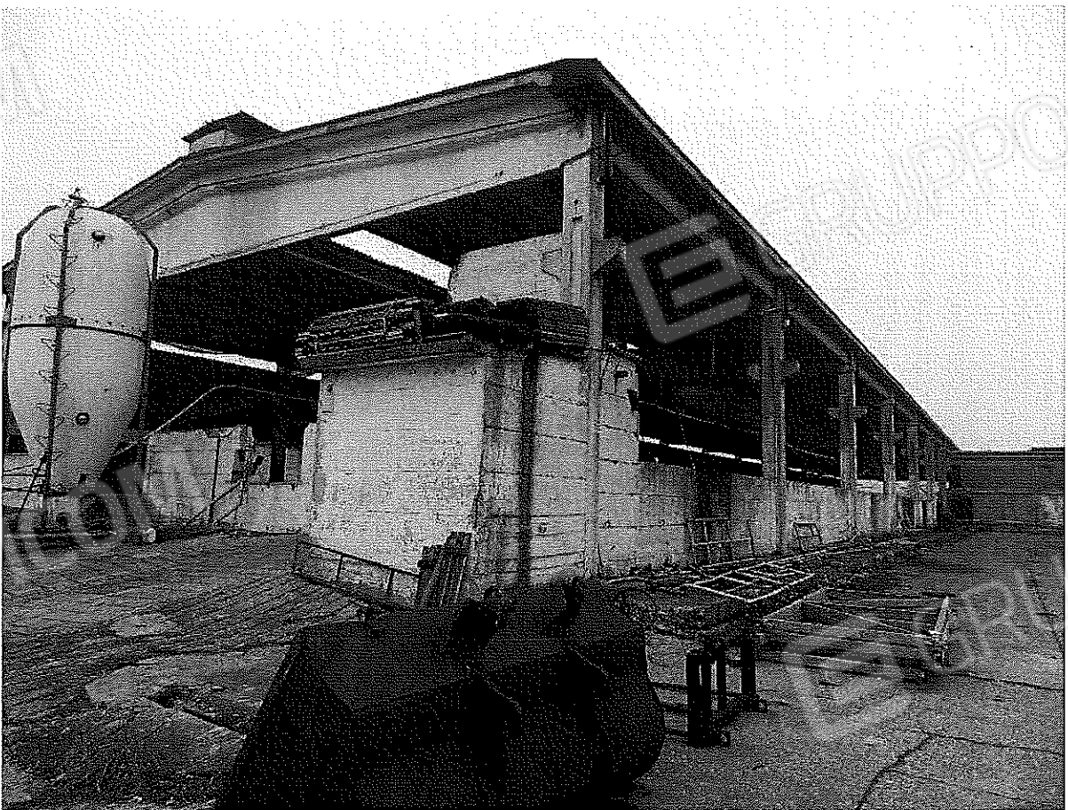
VISTA ESTERNA DELLA STALLA IN C.A.
