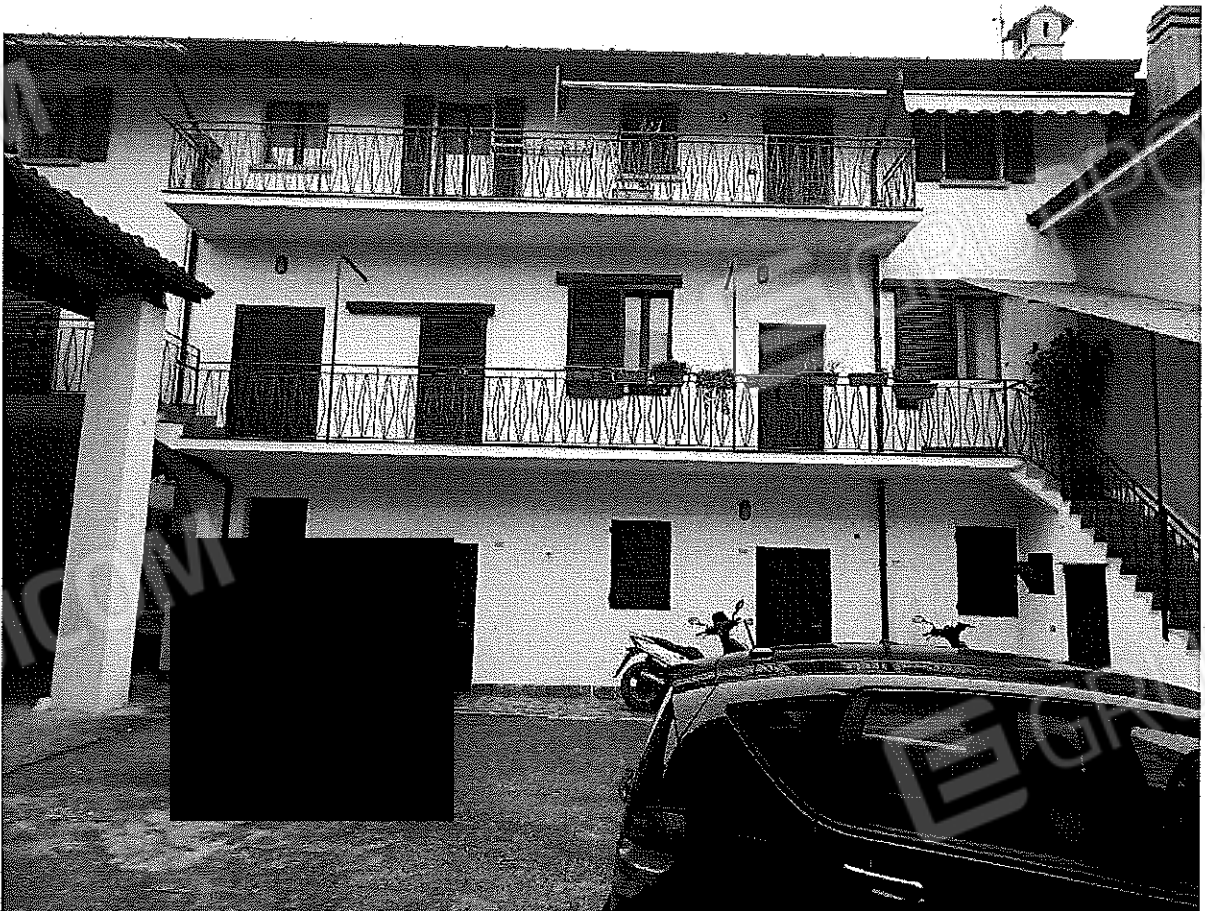
VISTA DEL FRONTE DEL FABBRICATO DAL CORTILE
