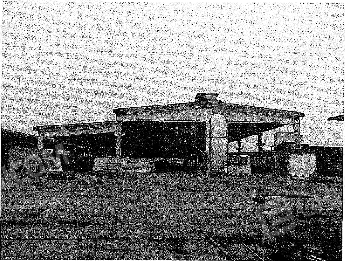
VISTA DA SUD DELLA STALLA IN C.A.
