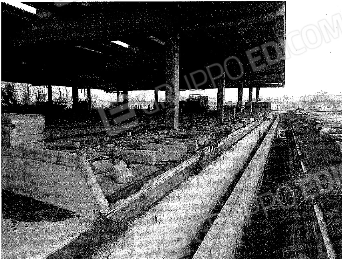
DETTAGLIO DELLA STALLA IN C.A. A NORD
