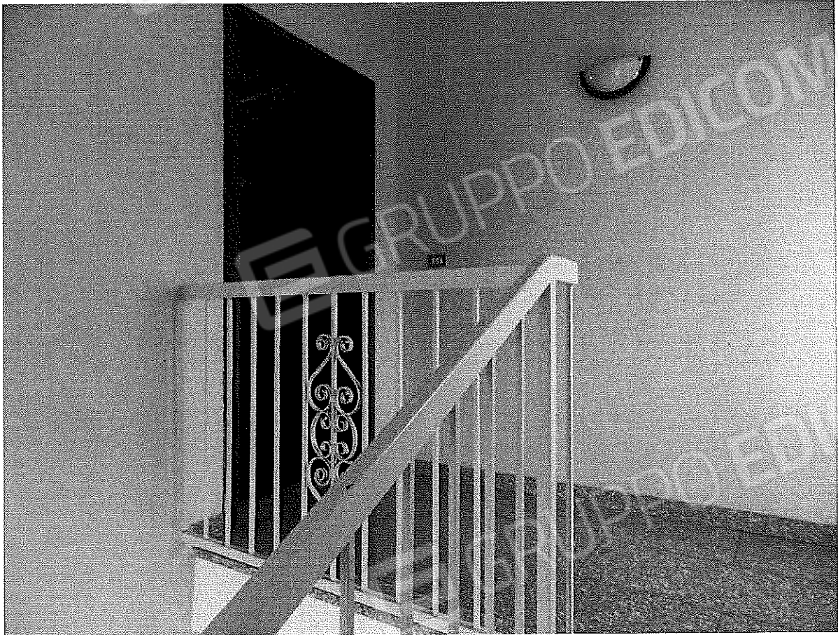
INGRESSO AL SOLAIO
