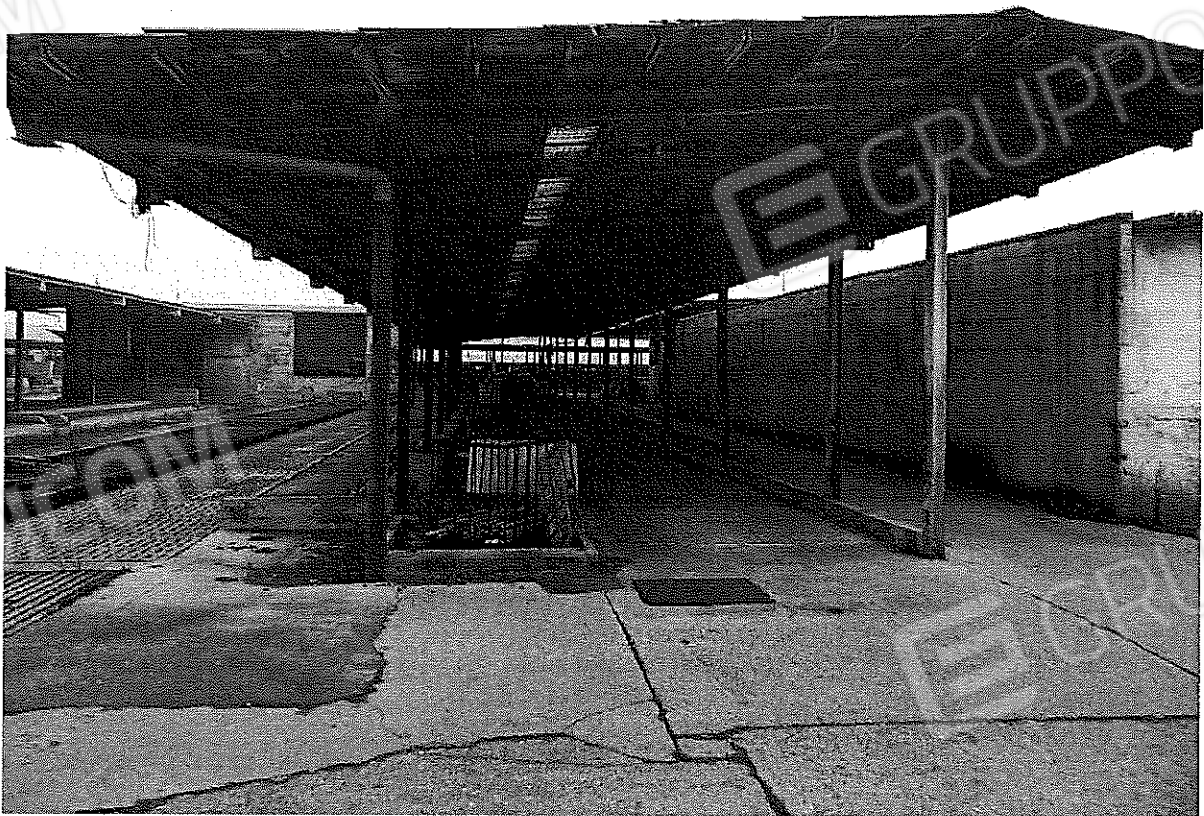
STALLA APERTA CON TETTOIA
