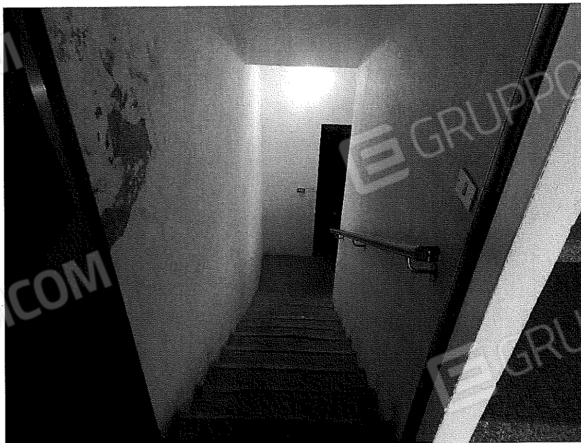
SCALA DI ACCESSO AL PIANO SEMINTERRATO
