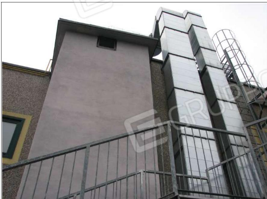
FOTO 15: particolare del vano ascensore e delle condotte di riscaldamento poste sul lato sud-ovest
