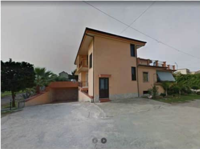
Foto 1: vista del fabbricato lato nord
