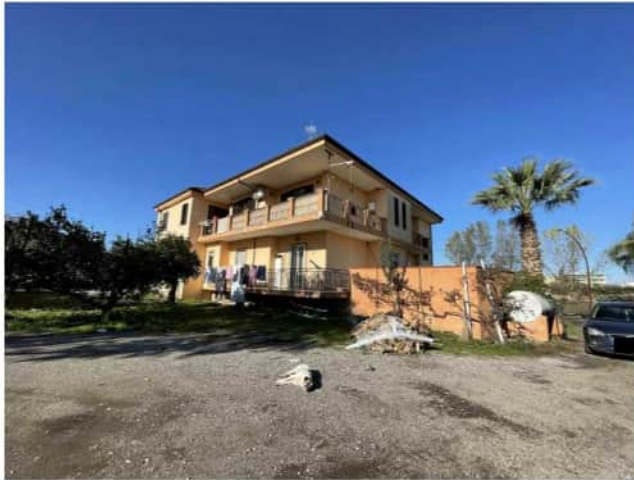
Foto 3: vista del fabbricato lato sud
