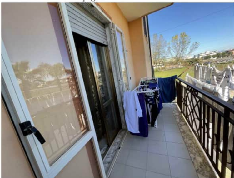
Foto 23: balcone lato est
