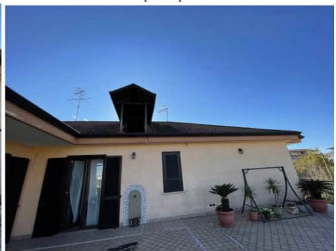
Foto 39: tetto non abitabile
