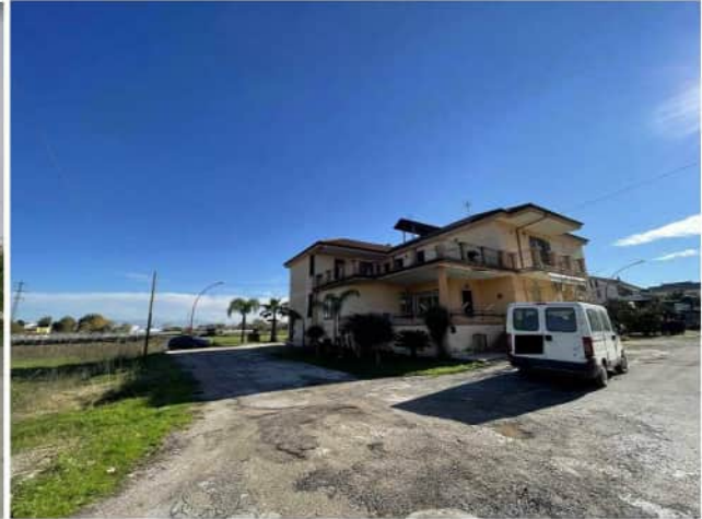
Foto 2: vista del fabbricato lato nord/ovest
