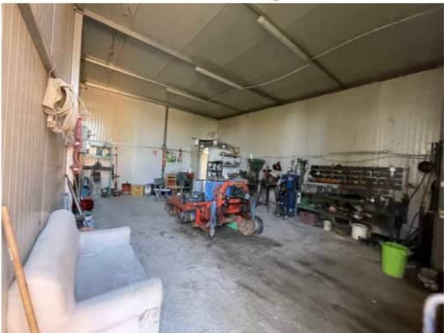
Foto 9: ricovero attrezzature porzione chiusa adibita ad ufficio
