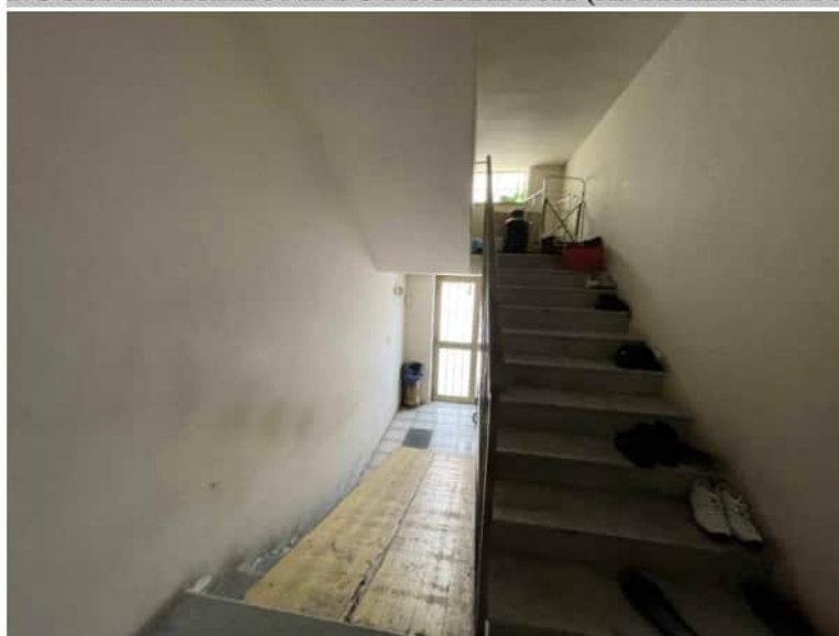
Foto 11: vano scala di accesso al piano rialzato
