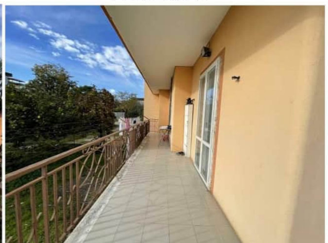
Foto 18: balcone lato sud
