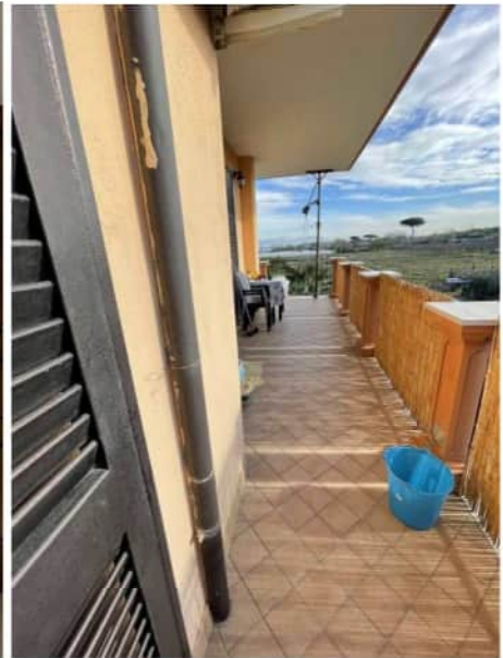
Foto 35: balcone lato sud
